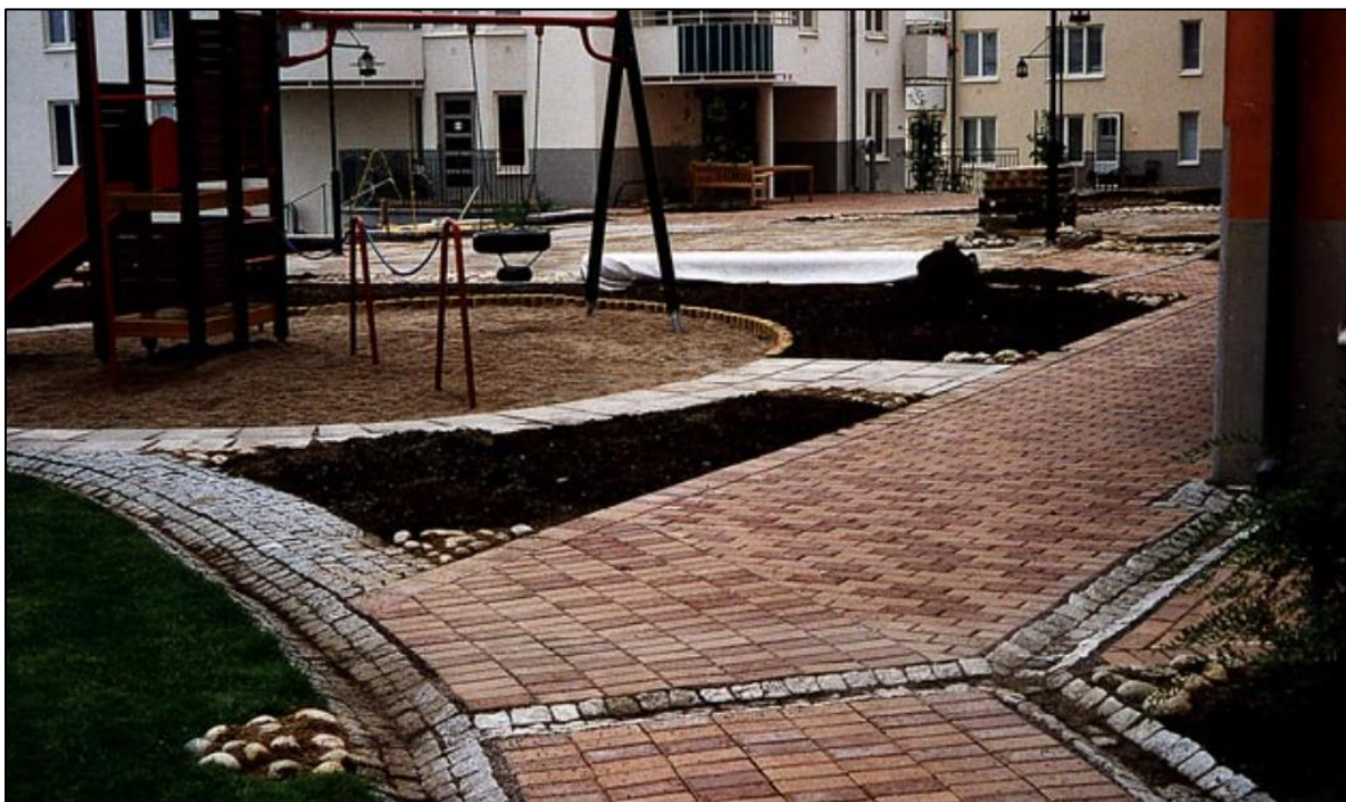
Figur 5-4. Exempel på avledning av takvatten via rännilar anlagda med gatsten (Källa: Stockholm Vatten AB, n.d.).
