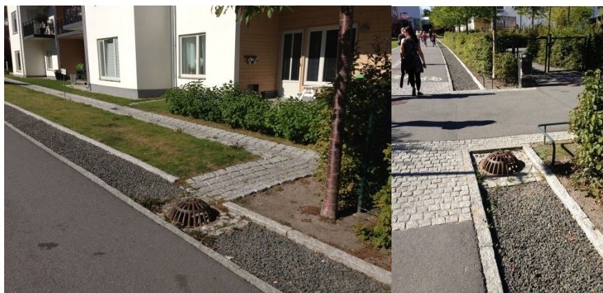
Figur 9. Exempel på avvattningsstråk med krossmaterial i Hammarby Sjöstad.
