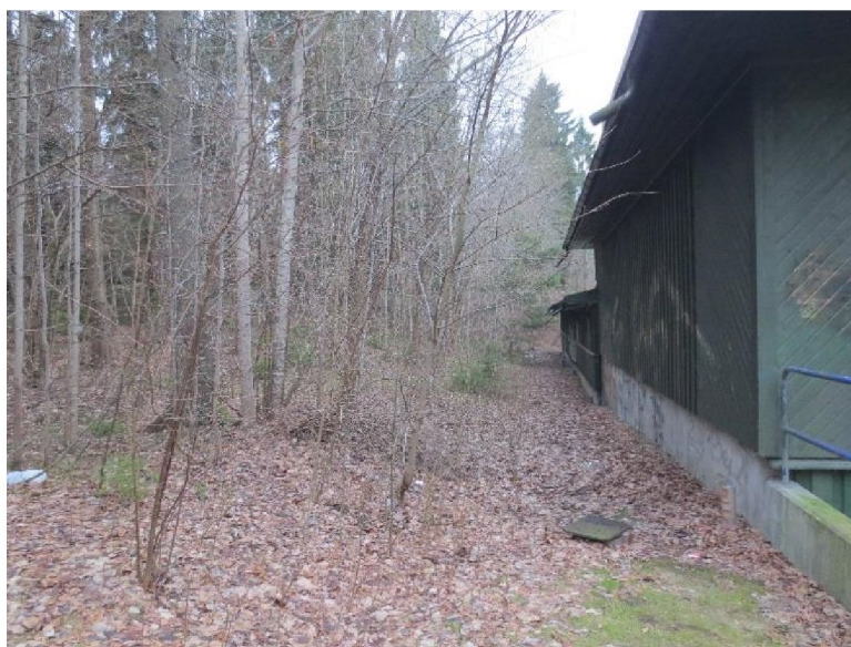
Figur 5. Vy från sydöstrahörnet. Avrinningsstråk från öst till väst bakom byggnaden. Här syns att stuprör tagits bort.
