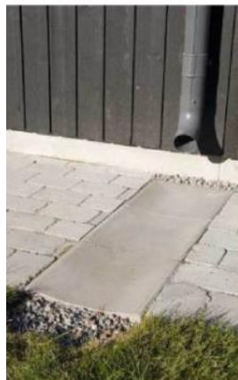
Fig.17 och 18 Utkastare-Stenkista, Novamark.
