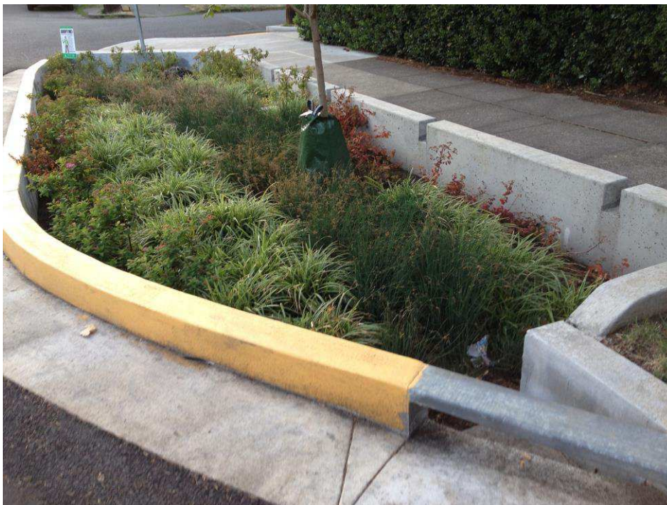
Figur 8. Exempel från Portland på nedsänkt växtbädd med träd och andra växter dit dagvatten från både väg och trottoar leds.
