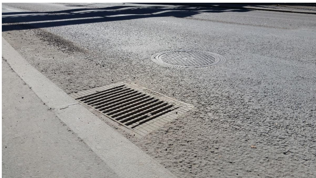
Figur 8 - Dagvattnet från Norra Hamnvägen avvattnas med hjälp av konventionella rännstensbrunnar.
