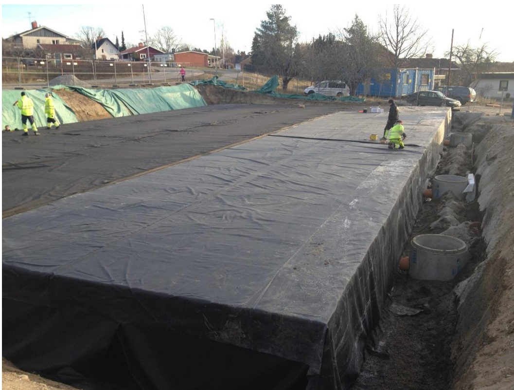
Figur 16 – Anläggning av fördröjningsmagasin med plastkassetter.
