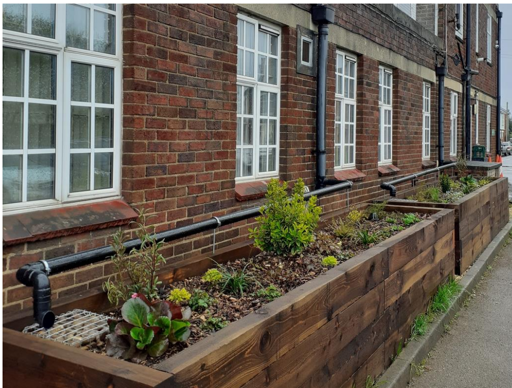
Figur 15. Exempel på upphöjd växtfilterbädd för fördröjning och rening av takdagvatten. 7 Liknande utformning kan nyttjas för rening av dagvatten från takytor.
