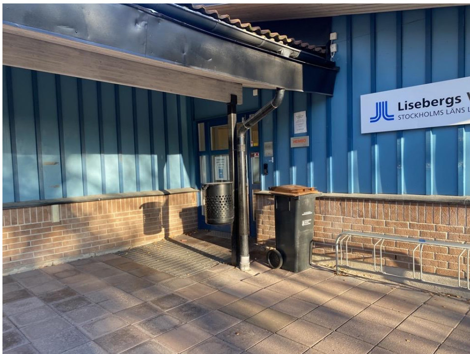
Figur 8. Läge B i Figur 6, takavvattning inom fastigheten leds på ledning med anslutning till kobinerad ledning
