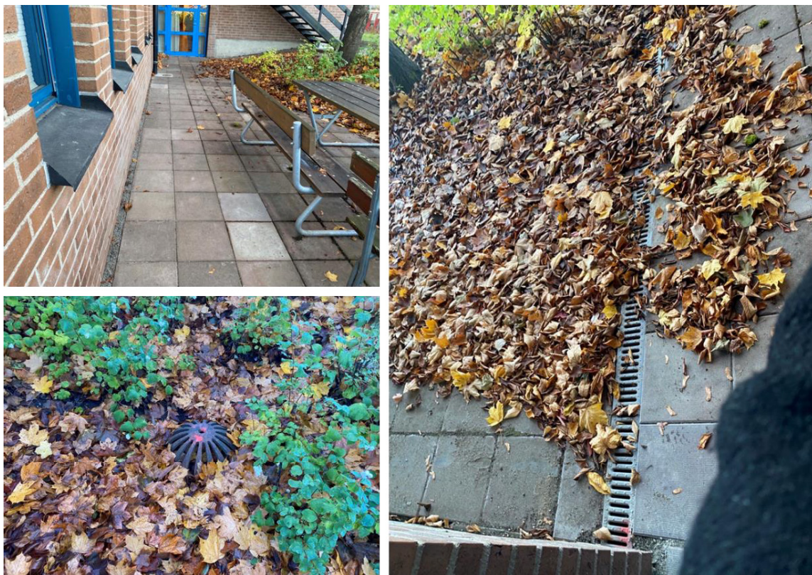
Figur 10. Läge D i Figur 6, Uteplats längs med norra fasaden, nedsänkt med kupolbrunn och ränna för skydd mot avrinning från högre belägna områden.
