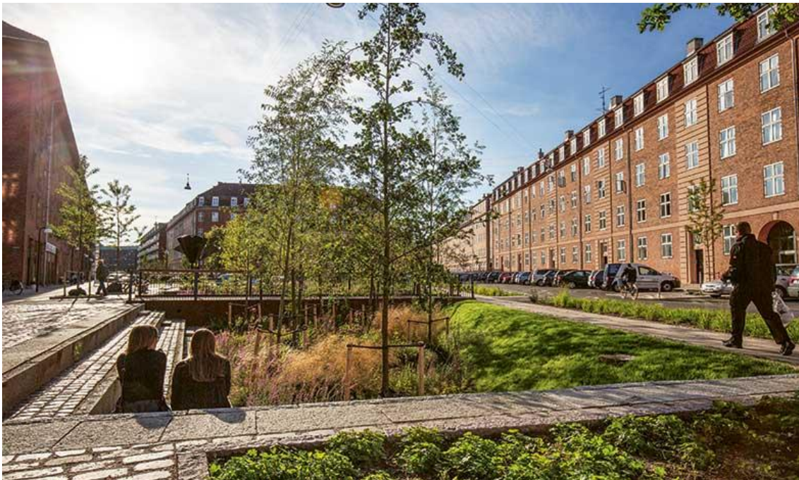
Figur 16. Stor nedsänkt regnväxtbädd. Vid små regn renas dagvatten via växtfilterytan i botten. Vid skyfall finns en stor volym ovan filterbädden som kan fyllas upp. 8
