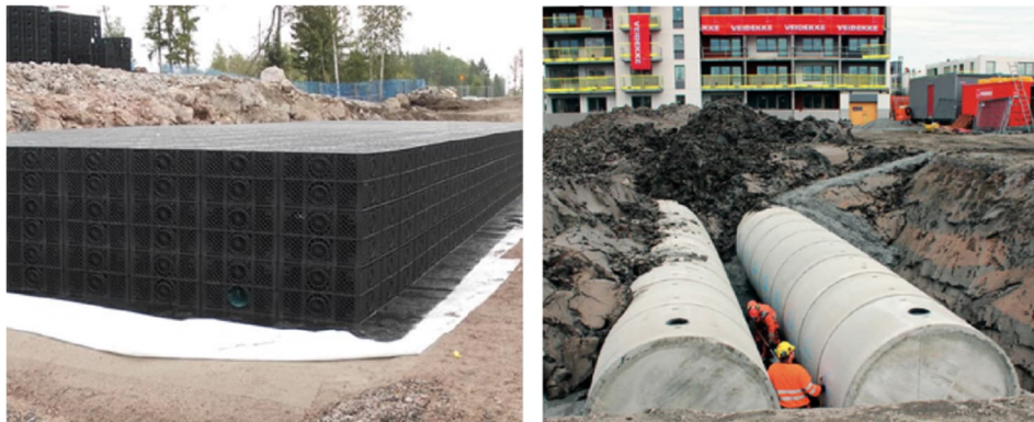
Figur 18. Exempel på hur avsättningsmagasin kan utformas. Vänster bild visar ett kassettmagasin från Uponor, högra bilden föreställer ett rörmagasin från Meag Va-system.
