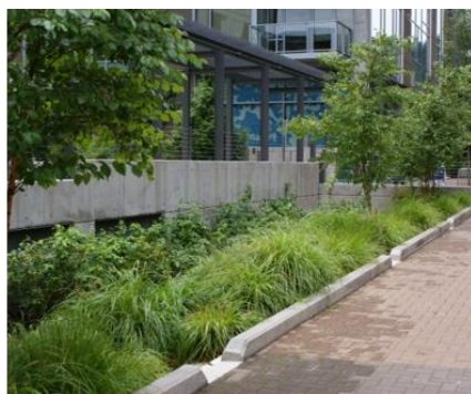
Figur 24. Olika kantstenslösningar för regnbädd. Foto: Sweco
