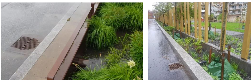
Figur 18. Bevattningsbrunn med sandfång och ytligt utloppsledning till växtbädd i kolmakadam, Norra Djurgårdsstaden Madängsgatan och Båthusparken.
