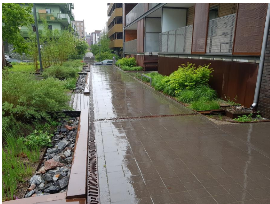
Figur 16. Ex. på utkastare från stuprör med rännalar till växtbädd.
