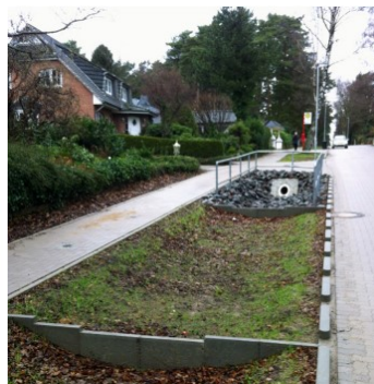
Figur 15. Principskiss makadamdike (t.v.) (källa: VA-guiden) och exempelbild på gräsbeklätt dike med dammen (t.h.).
