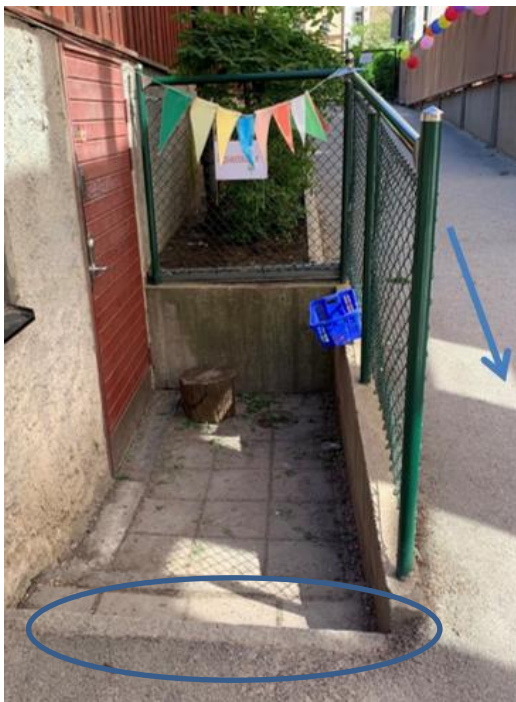
Figur 14. En av källarnedgångarna, norr om planområdet. Blåa pilen visar flödesriktningen. Blå ellips visar där det saknas en kantsten till källarnedgången.
