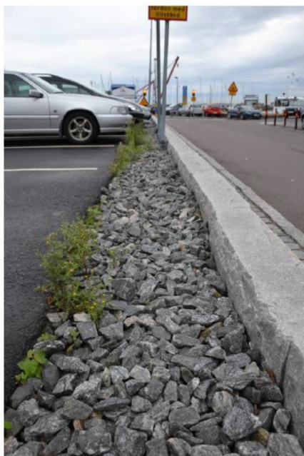
Figur 10-8. Parkering med intilliggande (i det här fallet) makadamlager.
