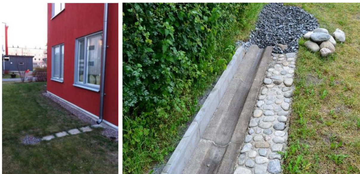
Figur 10-7. Utkastare med rännalar som leder vattnet till små stenistor i gräsmattan, exempel från Märsta i Sigtuna kommun, (T,h,). Dagvattnet når stenistan via en dagvattenränna, för hus utan källare rekommenderas att perkolationsmagasin anläggs minst två meter från huset, för hus med källare rekommenderas minst fem meter. Foto: poppelhus.se.
