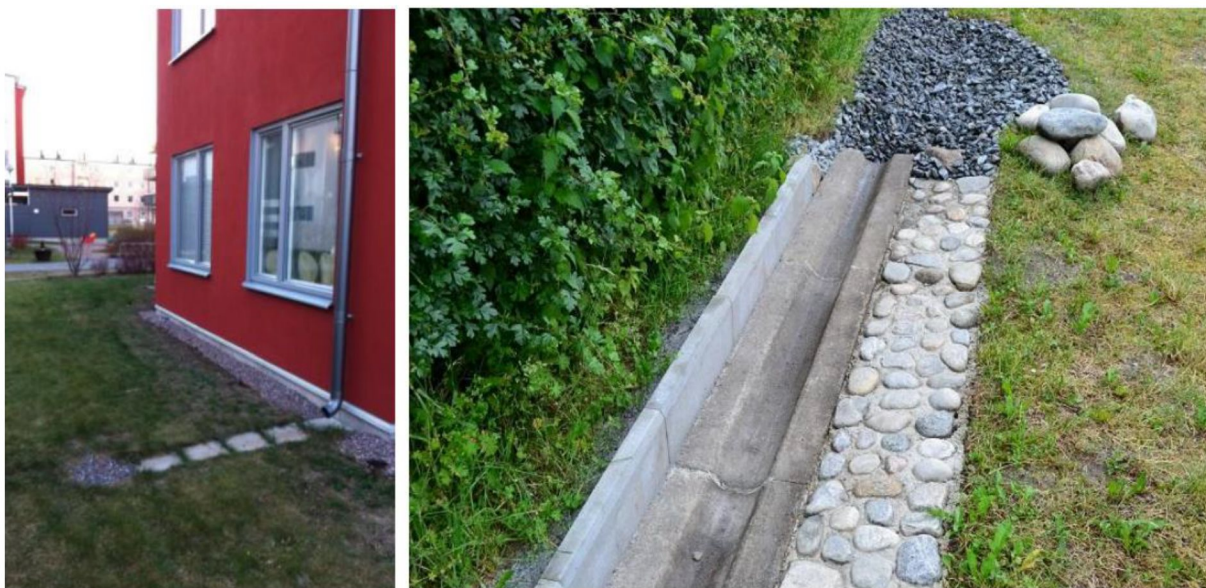
Figur 10-7. Utkastare med rännbäddar som leder vattnet till små stenkistor i gräsmattan, exempel från Märsta i Sigtuna kommun, (T,h,). Dagvattnet når stenkistan via en dagvattenränna, för hus utan källare rekommenderas att perkolationsmagasin anläggs minst två meter från huset, för hus med källare rekommenderas minst fem meter. Foto: poppelhus.se.
