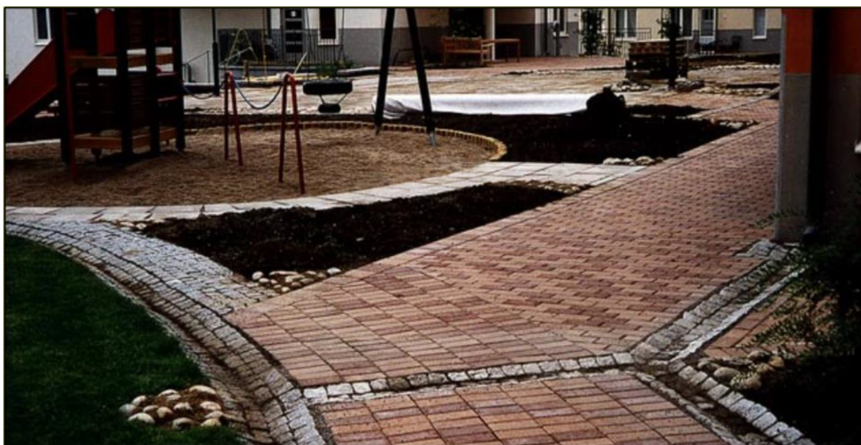
Figur 10-2. Exempel på avledning av takvatten via ränndalar anlagda med gatsten (Källa: Stockholm Vatten AB, n.d.).
