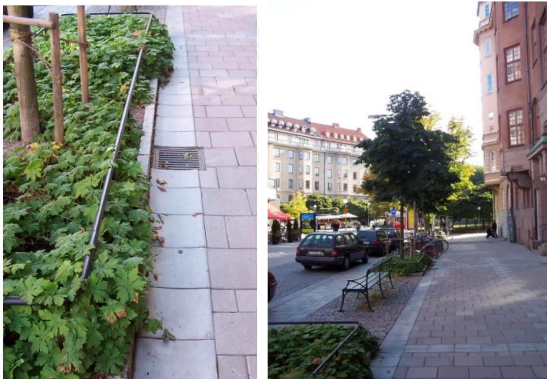
Figur 30. Vänstra bilden visar en vanlig rännstensbrunn som leds till skelettjorden intill. Högra bilden visar träd planerade i skelettjord på Erik Dahlbergs allé (Bildkälla: Stockholm vatten och avfall)
