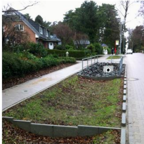
Figur 21 Exempel på diken med dämnen. TV svackdike med dämnen i form av genomsläpplig stenmur (foto J. Malmberg) TH Svackdike med dämnen i form av cementväggar (foto WRS),
