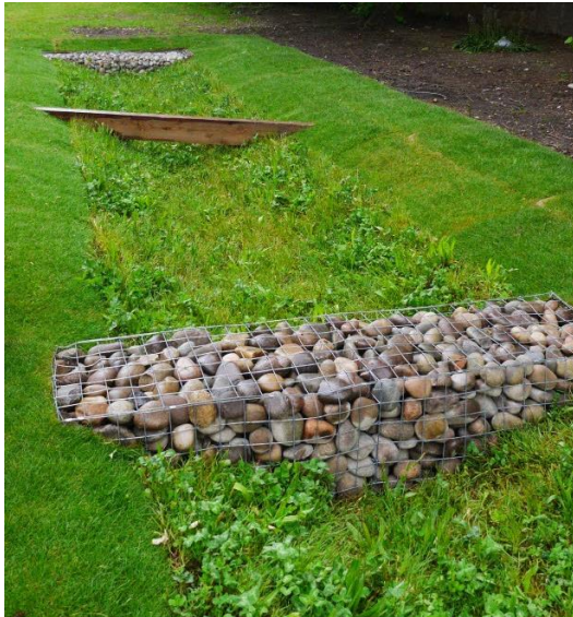
Figur 21 Exempel på diken med dämnen. TV svackdike med dämnen i form av genomsläpplig stenmur (foto J. Malmberg) TH Svackdike med dämnen i form av cementväggar (foto WRS),
