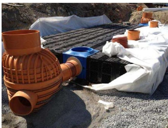
Figur 9. Dagvattenkassett och kassettmagasin under anläggning.
