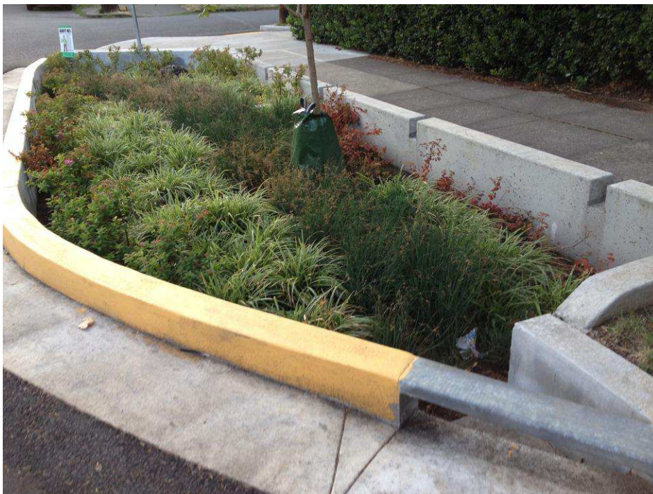
Figur 7. Exempel 2 från Portland på nedsänkt växtbädd med träd och andra växter dit dagvatten från både väg och trottoar leds.
