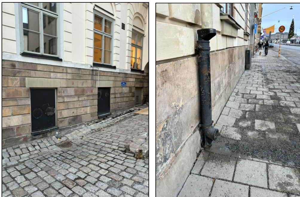
Figur 4.3. Vänster: Exempel på ränndal och rännstensbrunn på innergården. Höger: Utkastare från Argus 8 mot Skeppsbron.
