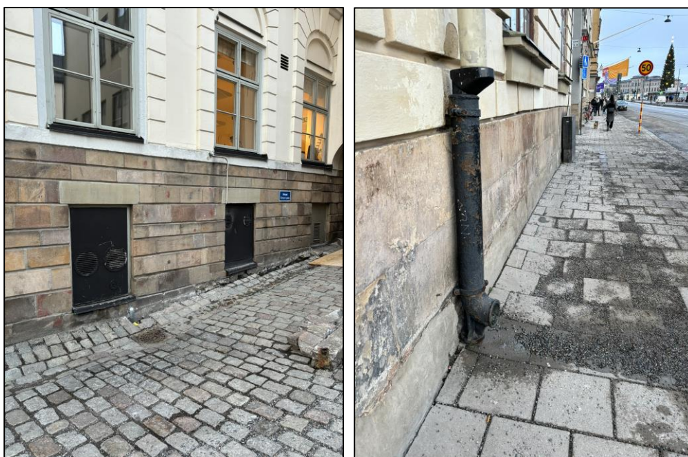
Figur 4.3. Vänster: Exempel på rännstal och rännstensbrunn på innergården. Höger: Utkastare från Argus 8 mot Skeppsbron.
