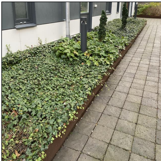
Figur 8.2 Nedsänkt regnbädd för omhändertagande av tak- och gårdsvatten. Foto: NIRAS Sweden.
