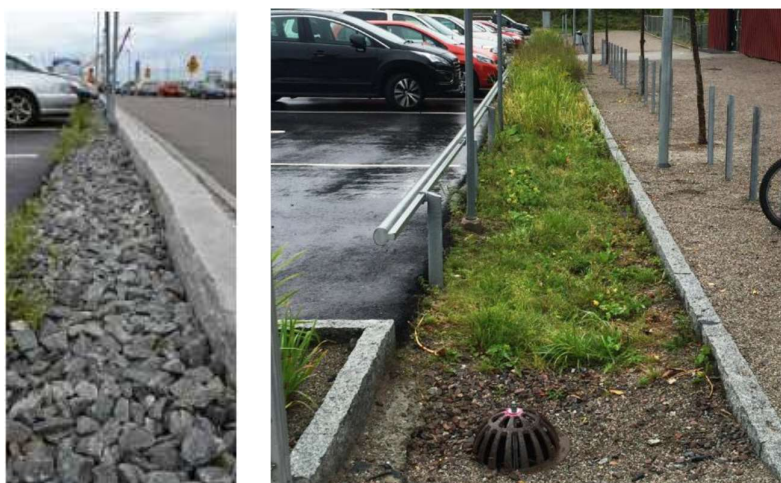
Figur 9 Exempel på stramare, mindre platskrävande fördröjning för dagvatten från parkeringsytor.
