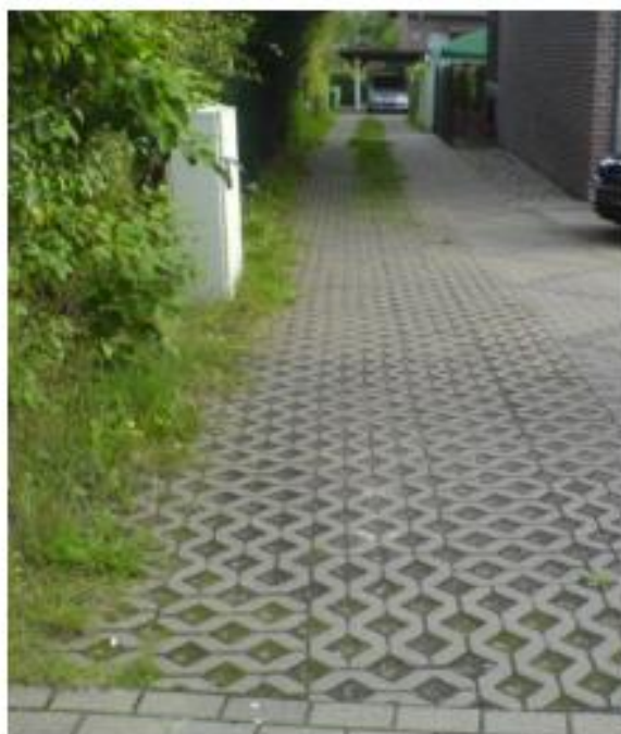
Figur 13 Exempel på genomsläpplig beläggning (Stockholm stad, 2017)
