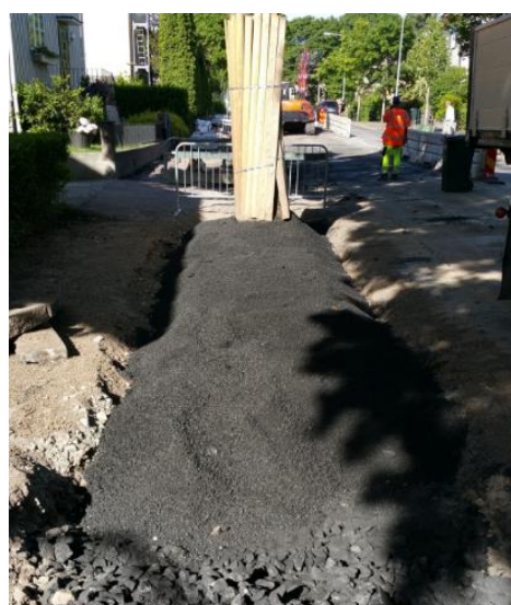
Figur 10 Exempel från en nedsänkt växtbädd från ett projekt i Norra Djurgårdsstaden och i Bromma-Nockeby. Dagvatten leds via en dagvattenbrunn med sandfång på gatan (bild på vänstra sidan).
