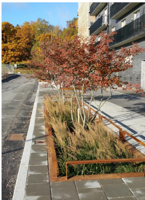
Figur 10 Exempel från en nedsänkt växtbädd från ett projekt i Norra Djurgårdsstaden och i Bromma-Nockeby. Dagvatten leds via en dagvattenbrunn med sandfång på gatan (bild på vänstra sidan).
