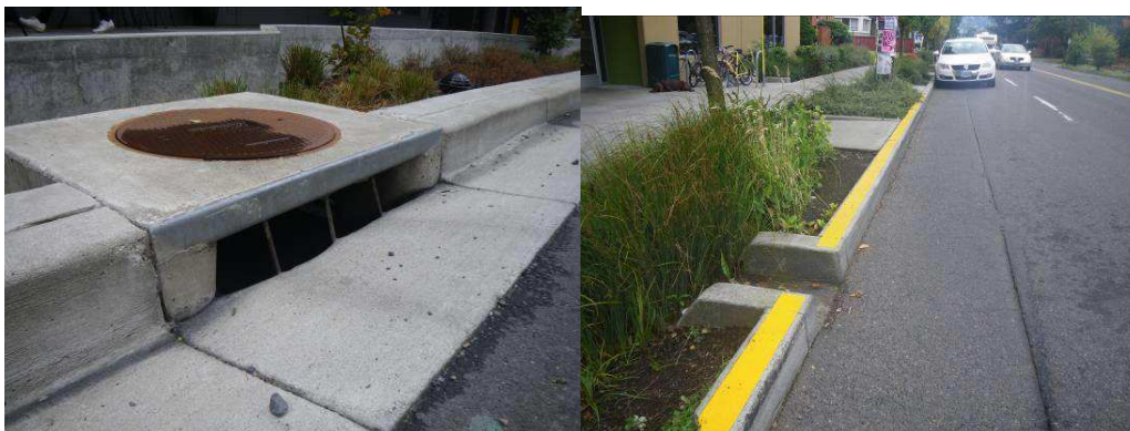
Figur 23 90-gradiga inlopp i Portland, Oregon, USA. Erfarenheterna ifrån dessa inlopp är att stor del av flödet rinner förbi istället för in i inloppet.
