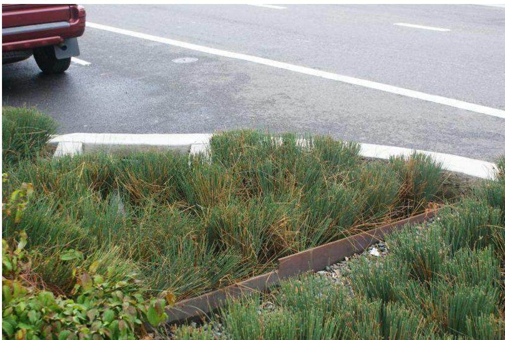
Figur 19 Dämme av cortenstål i växtbädd i Portland, Oregon, USA, 2010
