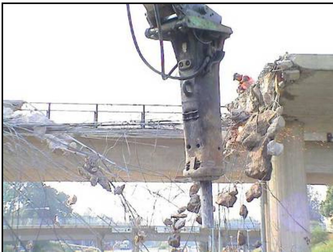
Figur 3.4.3. Rivning av bro med hydraulhammare (Källa: Entreprenad AB Sven Segerström)
