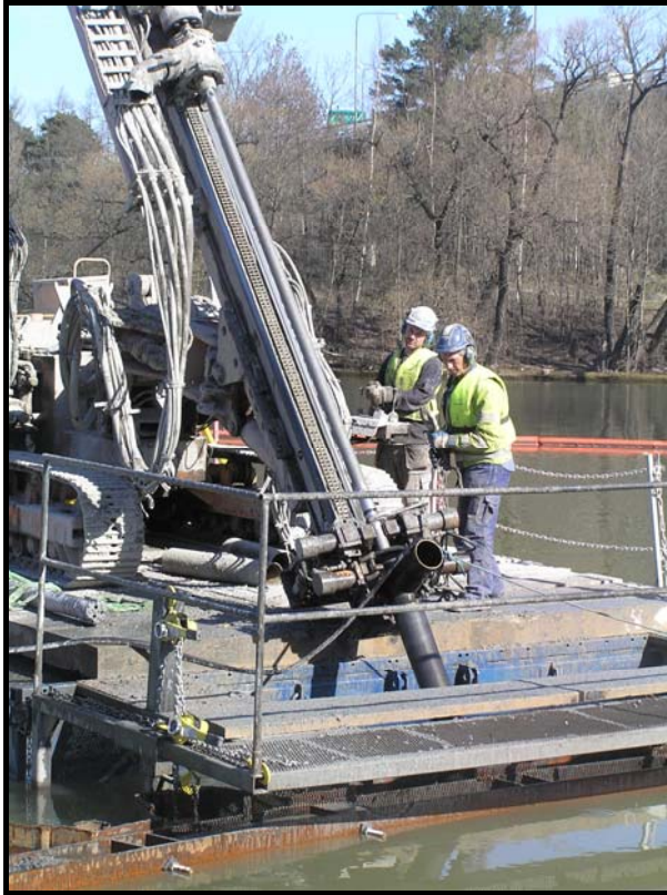
Figur 3.2.2. Borring av foderrör för spontförankring med bergstag (Källa: SWECO)
