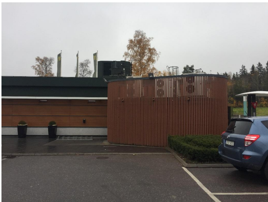
Figur 4. McDonalds har en större fläkt på taket och ett antal kylmedelskylare i en inbyggnad på gården. Fläkten har bara en mindre öppning åt fotbollsplanen. Kylmedelskylarna kan tänkas gå med högre fart på sommaren. Buller från McDonalds kommer inte påverka skolgården men lite buller påverkar skolans fasader som vetter år detta håll.
