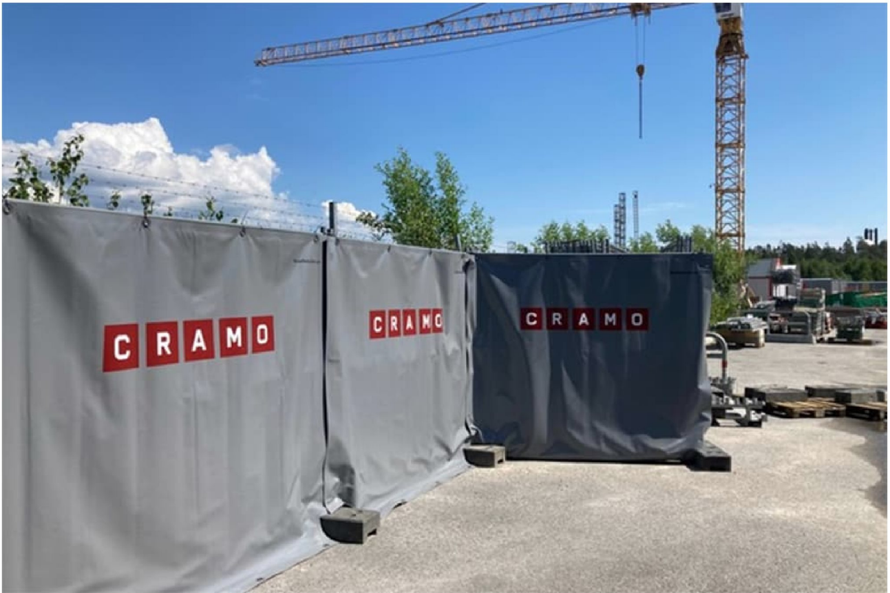
FIGUR 2. EXEMPEL PÅ TEMPORÄRT BULLERSKYDD VID ARBETSPLATS.
