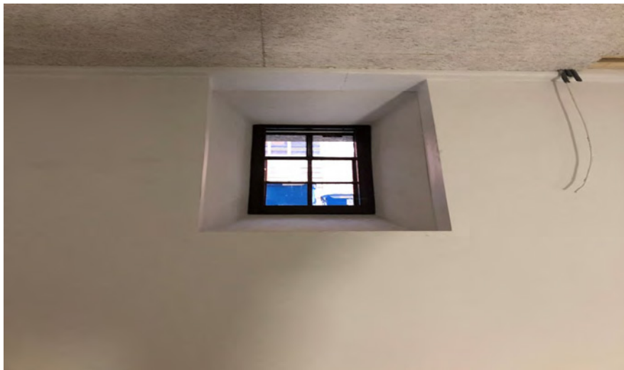
Bild 12 från hus 8 som visar inklädnad av källaryttervägg.
