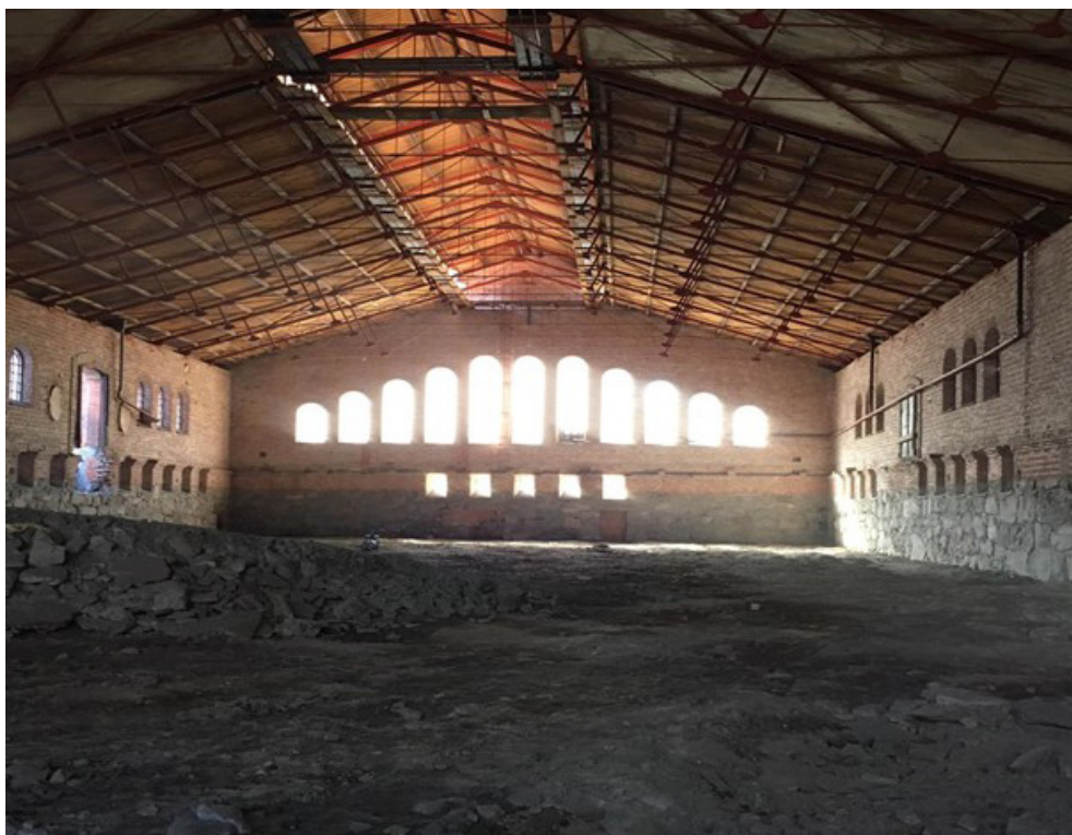
Bild 8 som visar hus 8 efter att källargrunden av granit blästrats samt efter putsen på teglet bilats bort.
