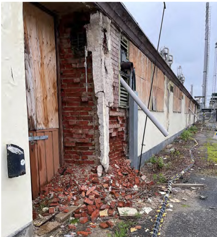
Bild 36 från 2022 som visar hus 15/16's nedbrytning. Här det högporösa teglet.
