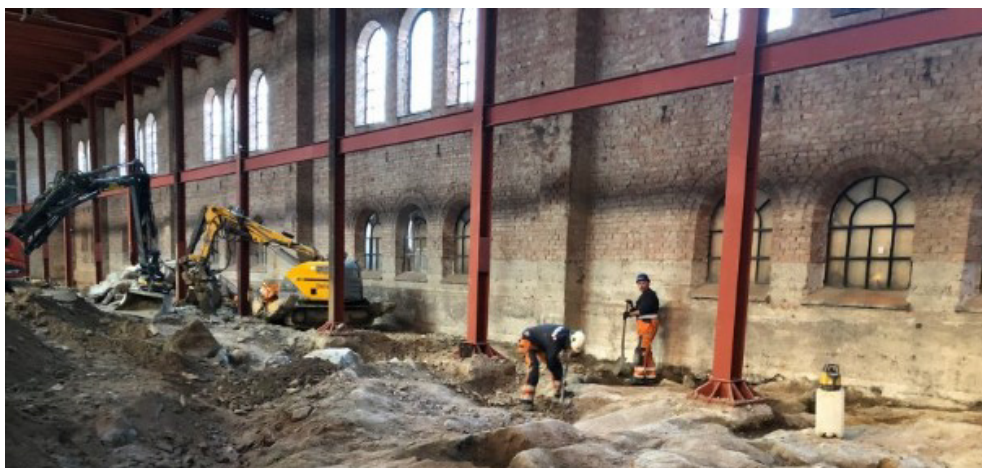
Bild 9 från hus 10 när betongplattan är borttagen och hur schaktarbeten utförs.
