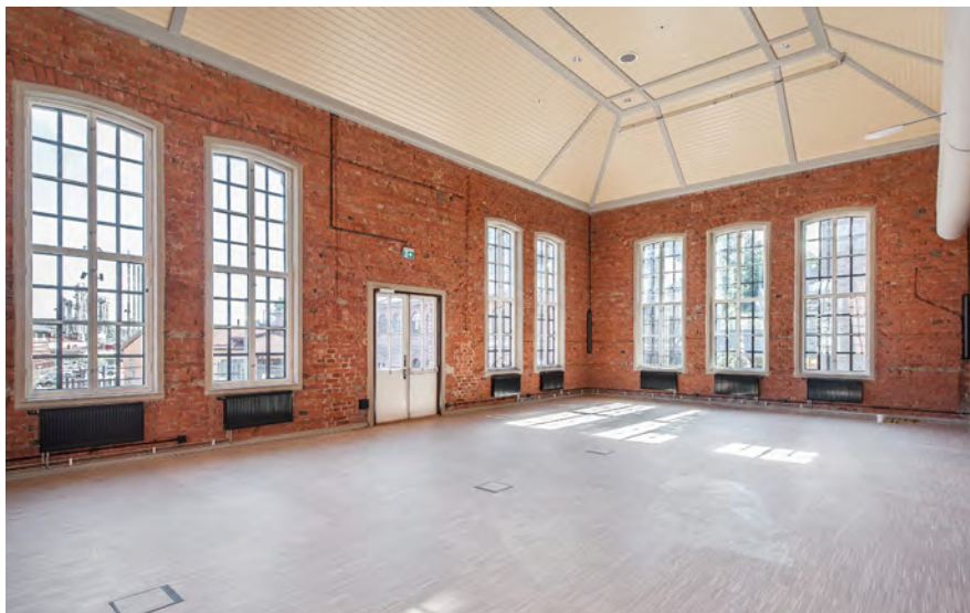
Bild 10 från hus 10 som visar tegel och fönster efter sanering och renovering och efter väggen behandlats med vattenglas.
