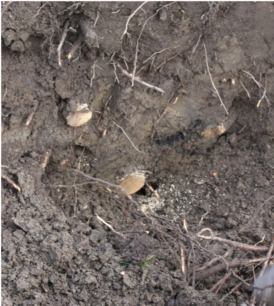
Figur 4. Korrekt beskurna rötter vid schakt.
