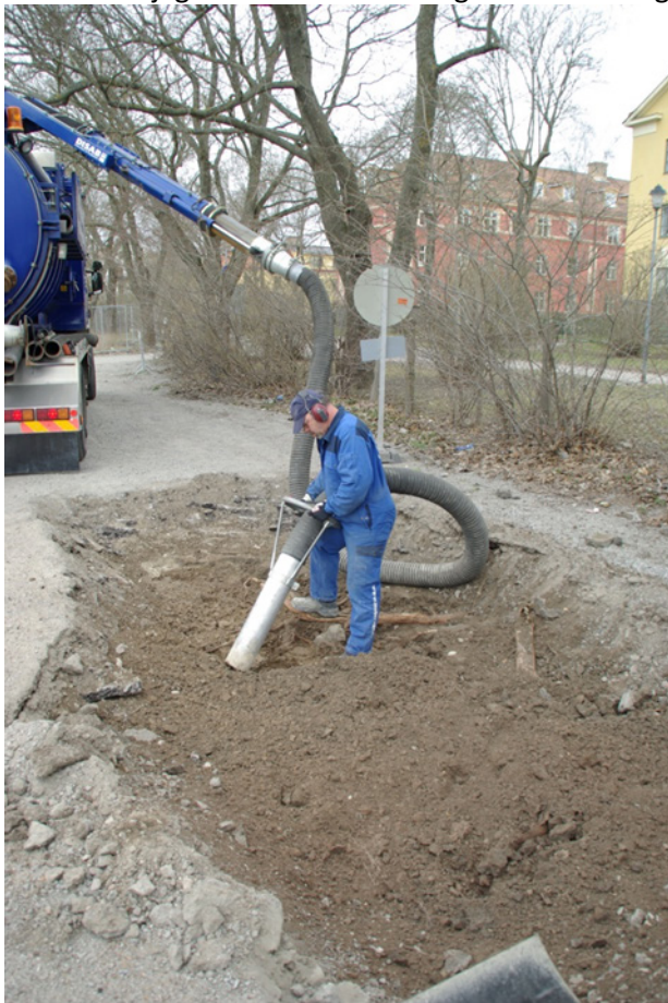
Figur 2. Rotkartering med vakuumschakt.
