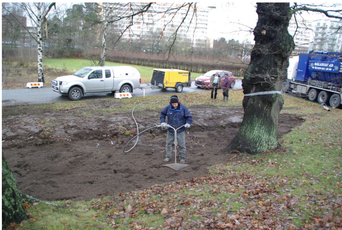
Figur 1. Luckring inför en markvitalisering
