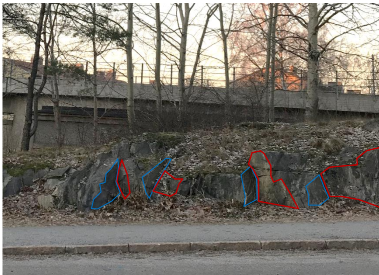
Figur 2-5 Exempel på kilbildning i västra bergslänten vid Malmövägen. Blå linje markerar kontur i sprickplan som formas av sprickgrupp S1. Mörkröd linje markerar kontur i sprickplan som formas av sprickgrupp S2.
