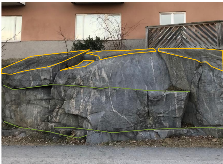
Figur 2-6 Exempel på strukturer i västra bergslänten vid Malmövägen. Grön linje markerar sprickplan som formas av sprickgrupp S3. Orange linje markerar kontur i sprickplan som formas av sprickgrupp S4.
