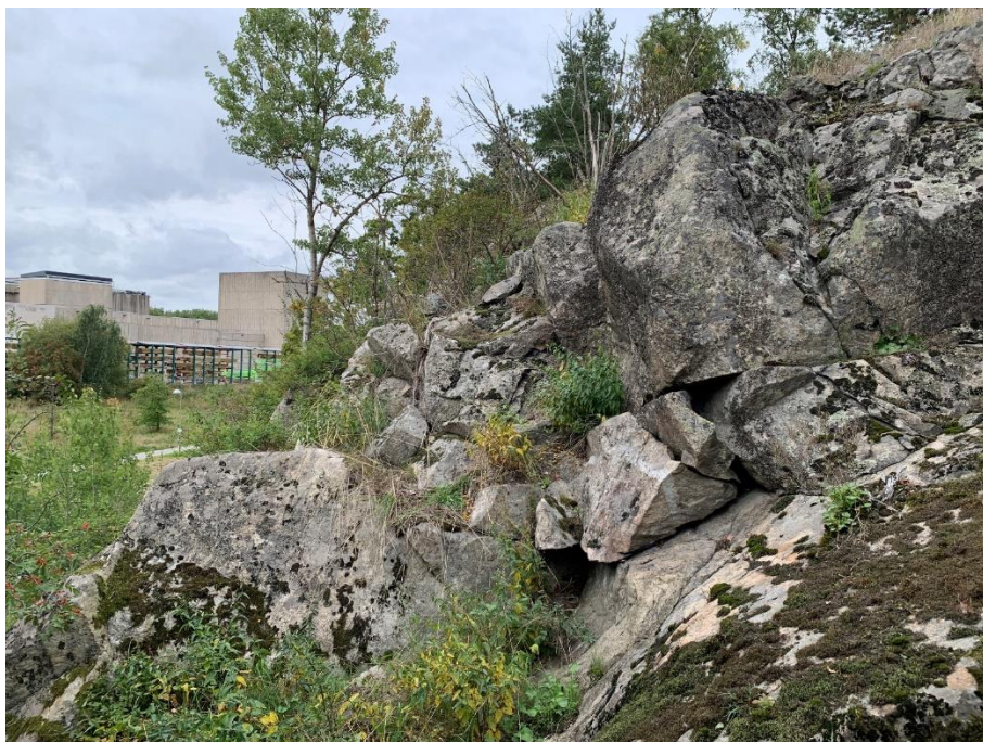
Figur 39: Utseendet av bergslänten från sidan. Lösa block som sitter fasta.
