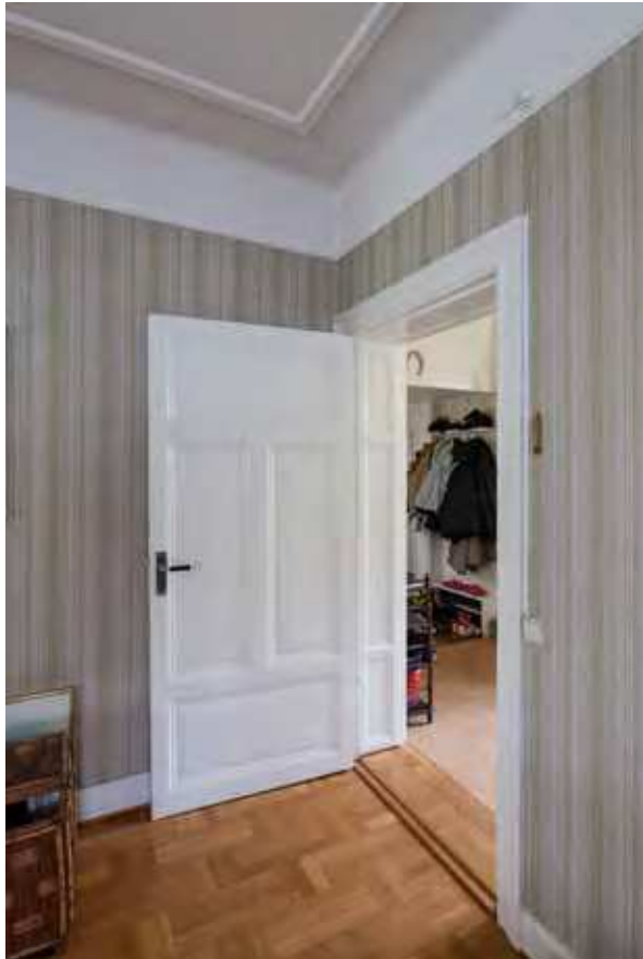
Dörr mot rum 11. Exempel på äldre dörrblad med profilerat foder på bottenvåningen. ME SSM_10001969S
