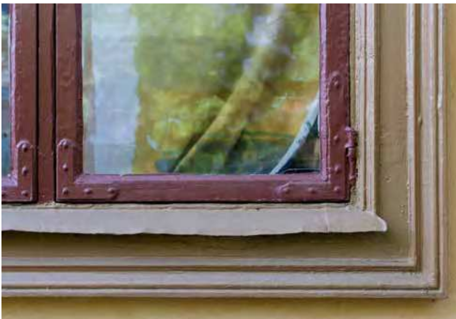
Detalj av fönster med äldre foder samt ytterbåge med smidda gångjärn och beslag. ME SSM_10002197S
