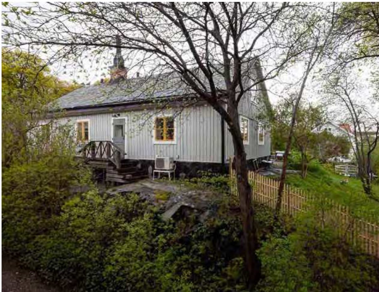
Mangelbodsvillan från sydväst. Det bevarade skiffertaket är en viktig kulturhistorisk kvalitet. Taket kompletterades omkring 2010 med nya skifferplattor, som avviker något i nyans från de äldre. ME SSM_100020655
