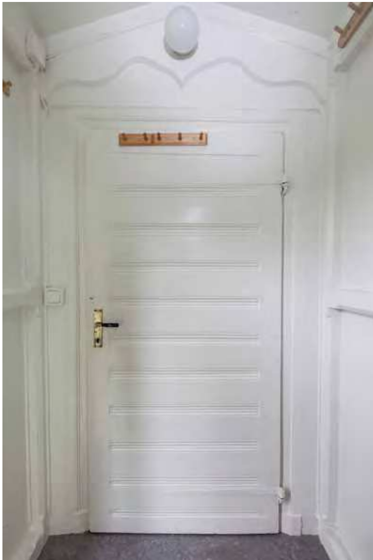
Mot rum 21 sitter en äldre bräddörr med profilerad liggande panel och smidda bandgångjärn. ME SSM_10001957S
