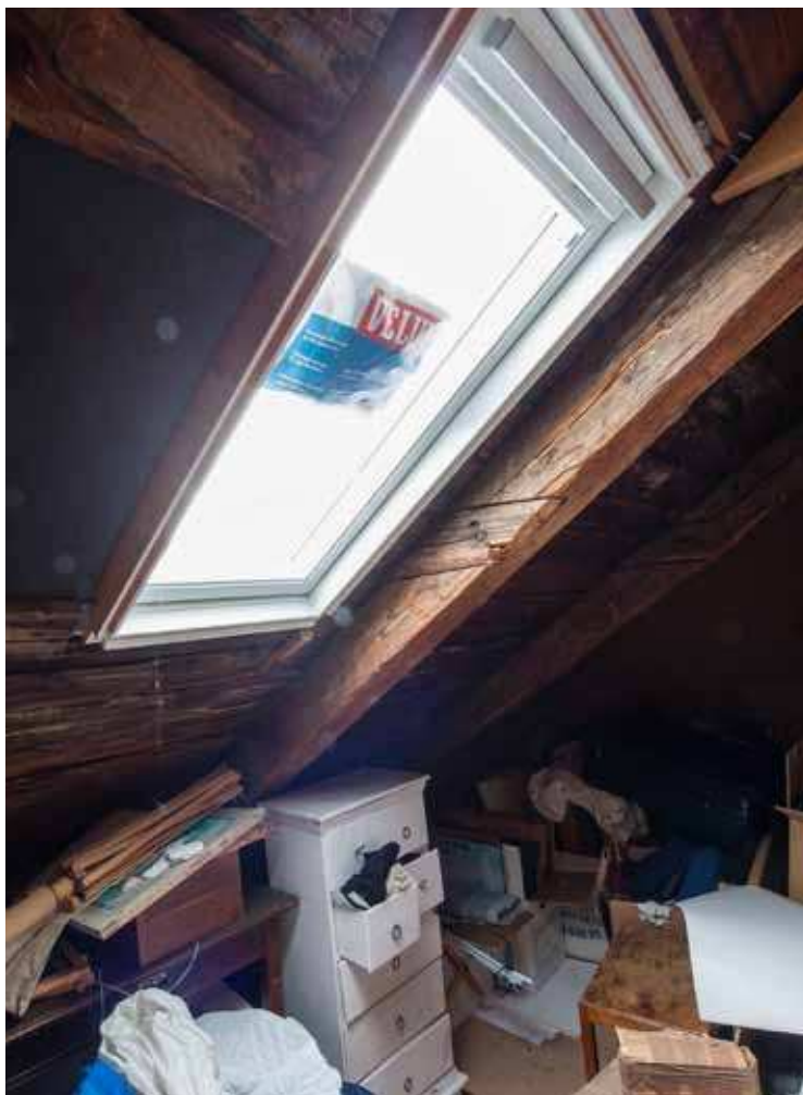
Utrymme med synlig takstolskonstruktion i vindsvåningens södra del. Vindsvåningens takfönster tillkom i samband med en ombyggnad under 1980-talet. ME SSM_10002074S
