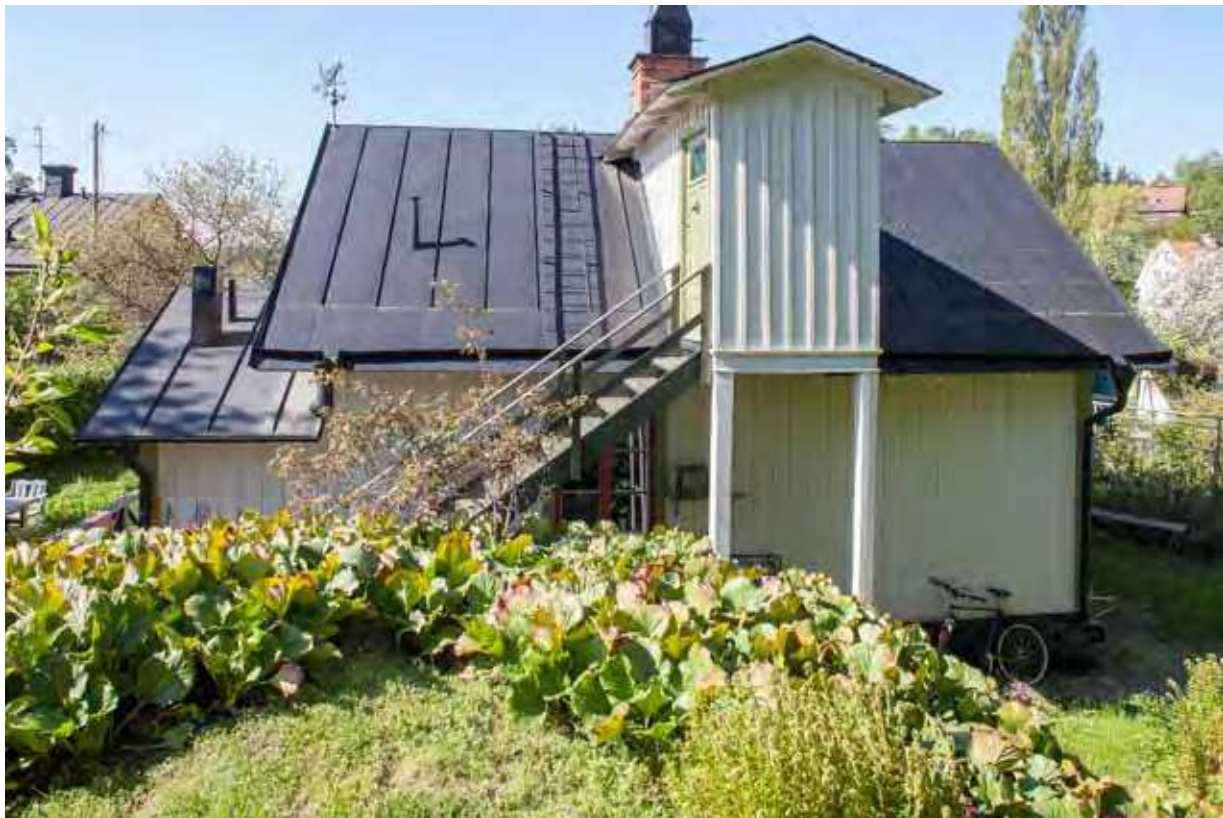
Alphyddan från nordost. Fasadpanelen på den nordöstra fasaden är sekundär och har bytts i senare tid. ME SSM_10002104S
