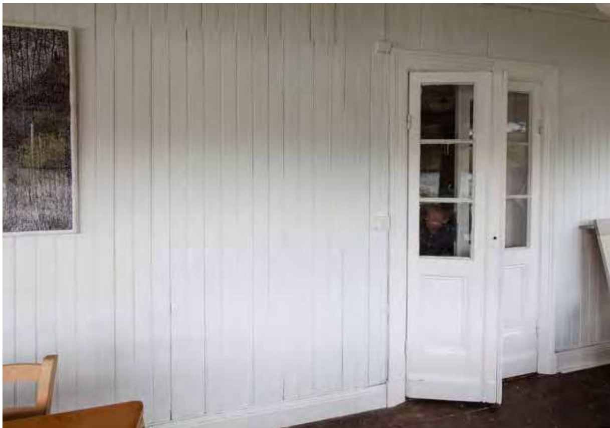
Pardörr mot rum 224 har en sekundär placering. Det ursprungliga läget markeras genom synliga skarvar i den bakre väggens pärlspont. ME SSM_10002066S
