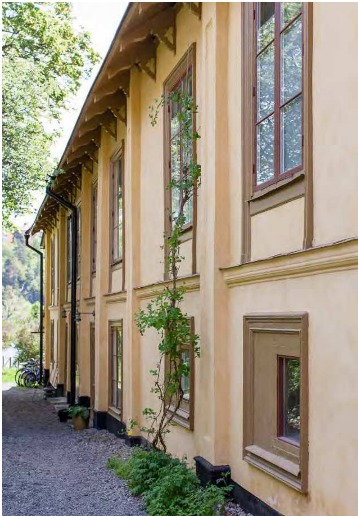
Den östra fasaden från nordost. Profilerade sparrändar och konsoler ger stöd åt byggnadens överskyggande tak. Timmerstommens knutlådor har infogats i den arkitektoniska gestaltningen i form av putsade lisener. ME SSM_10002218S
