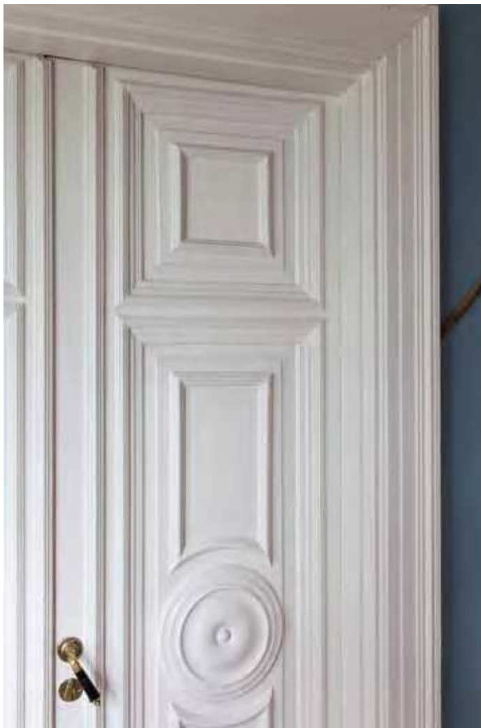
Rum 228 mot nordost. Våningsplanet uppvisar flera olika typer av sockelpaneler, här syns en slät variant med profilerad mittelbandslist. ME SSM_10002057S
