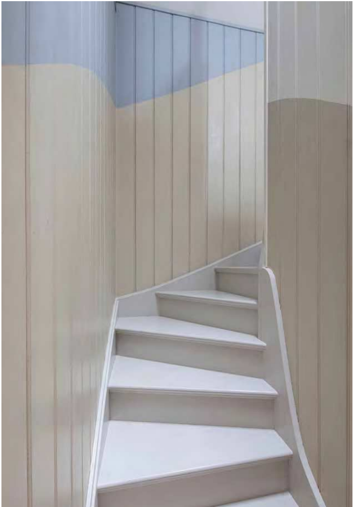
Rum 240/243 mot nordost. Trappan är sekundär och flyttad till nuvarande placering i samband med inredningen av vinden under 2000-talet. ME SSM_10002002S
