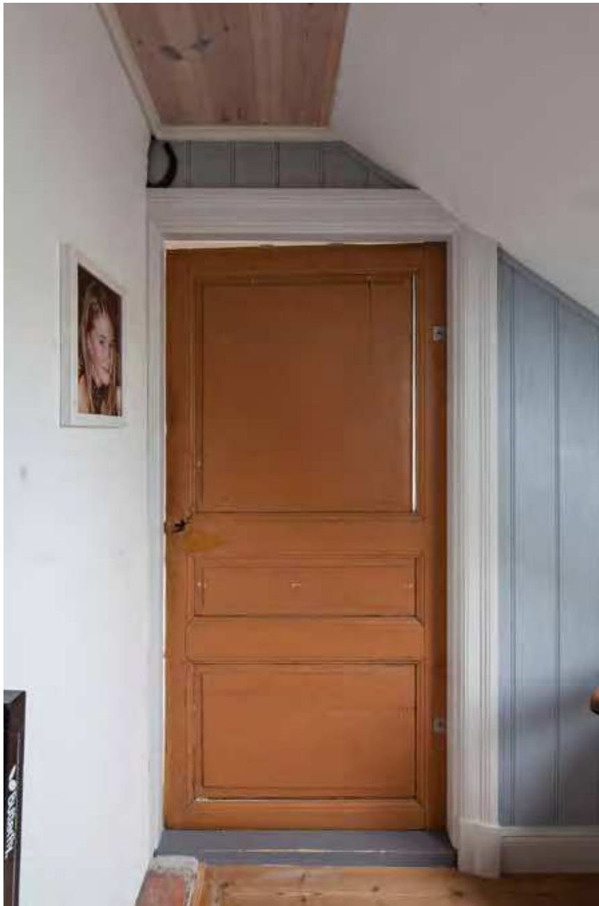
Äldre fyllningsdörr i rum 360 från 1800-talet, tidigare placerad i trapploppet mot vindsvåningen. ME SSM_10002012S
