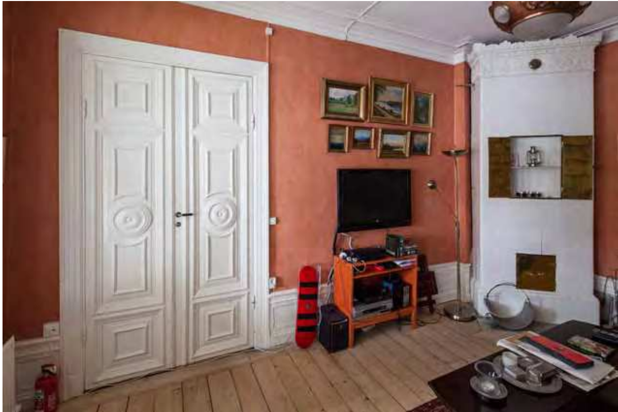
Rum 249 mot norr. Rummet uppvisar äldre fast inredning som förekommer i flera rum på våningsplanet såsom, sockelpanel, brädgolv, kakelugn, profilerad taklist i stuck liksom snickerier i dörrar och foder. ME SSM_10001991S
