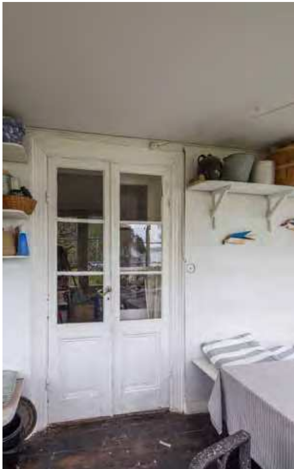
Äldre pardörr mot rum 108 med glasad överdel och mässingstrycke. ME SSM_10002034S
