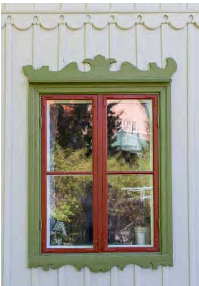
Detalj av fasadpanel med dekorativ fris samt fönster med bevarade överstycken och foder. ME SSM_10002110
