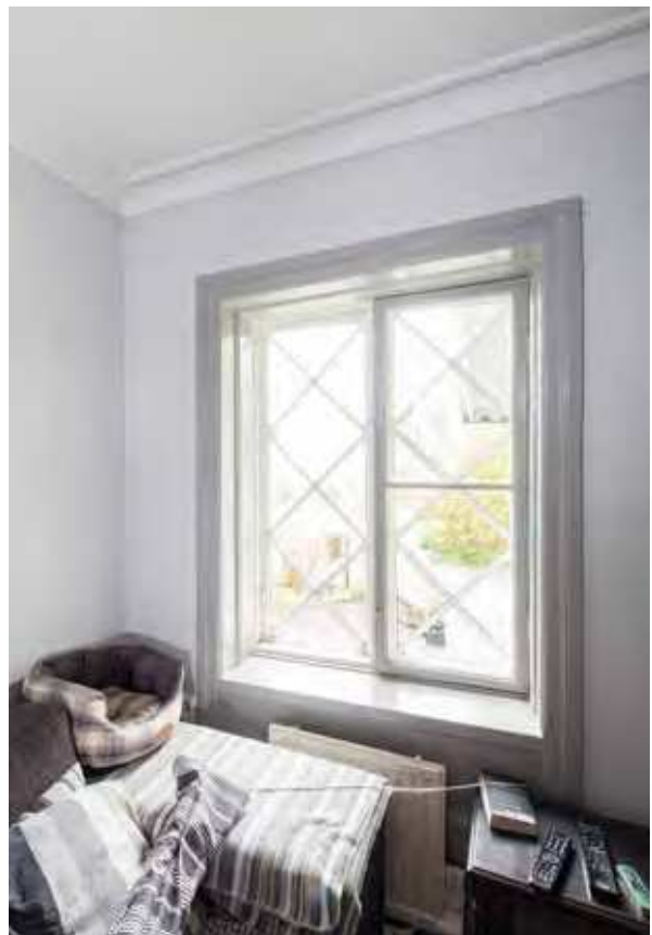
Fönster med äldre krysspräjsade ytterbågar i rum 15. ME SSM_10001948S
