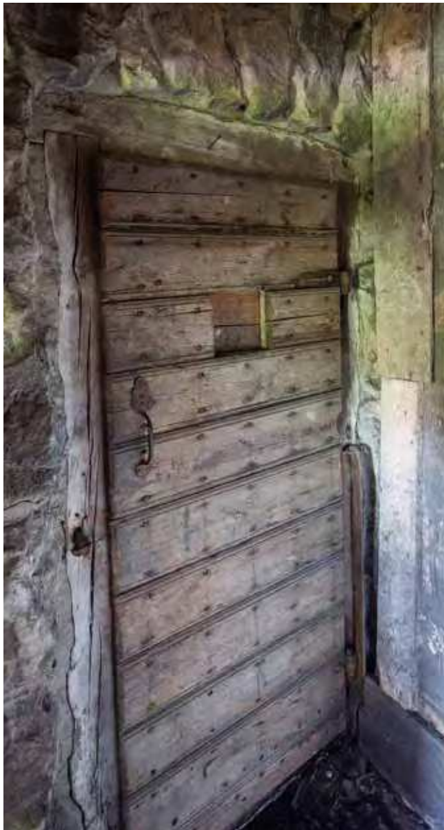
Exempel på förrådsbyggnadens äldre interiörer, koncentrerade till byggnadens västra del. Här är väggarna murade av natursten och taken av tegel. På bildens syns en äldre dörr med liggande panel, smidd spik och dekorativt handtag i järnsmide. ME SSM_10002229S
