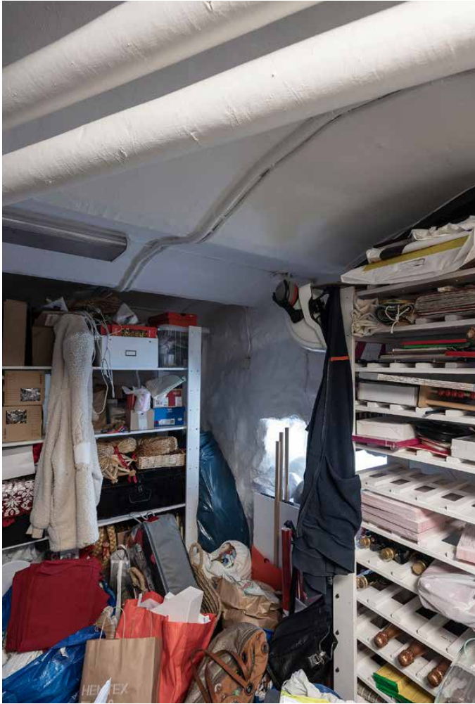
Källaren i riktning mot sydost. Det välvda taket är ett så kallat bremervalv, flacka tunnvalv av tegel mellan i-balkar av järn. SSM 10067780
