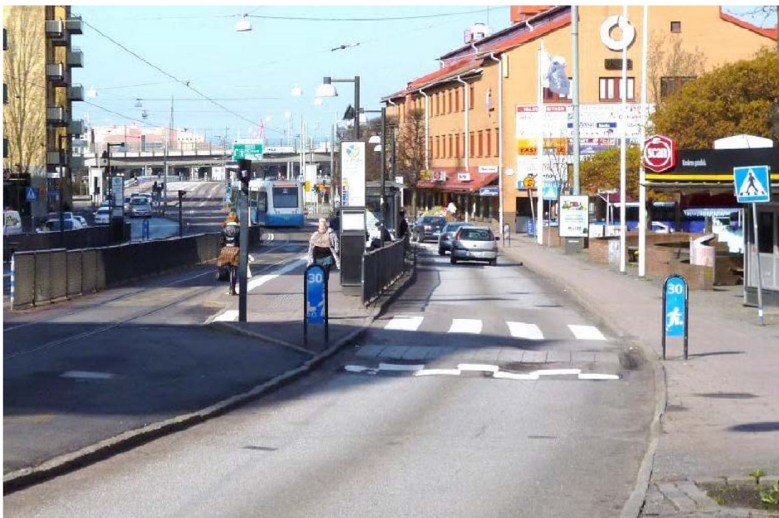
Figur 15 visar spår i gatumiljö i reserverat utrymme där ljussignal och kontrastmarkeringar hjälper till att uppmärksamma resenärer på de olika trafikslagen. Foto: Robert Olofsson.
