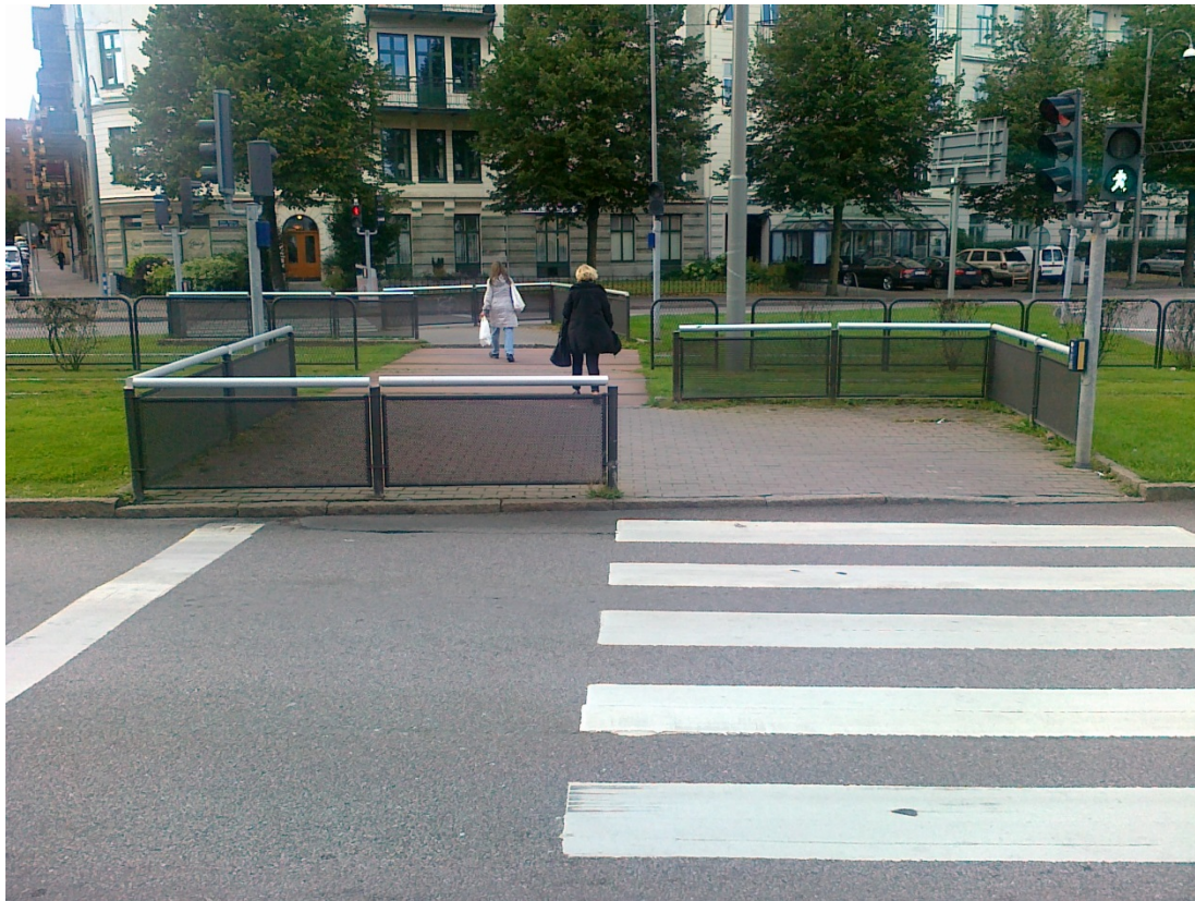
Figur 25 visar en lösning med chikaner i Göteborg.
