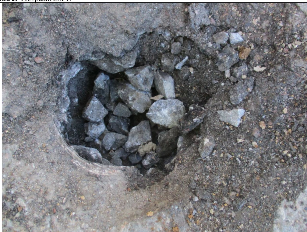
Bild 4. Borrhål för SM 2, stenfyllning under asfalt.
