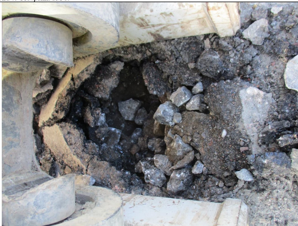
Bild 8. Provpunkt SM 8, stenfyllning under asfalt.
