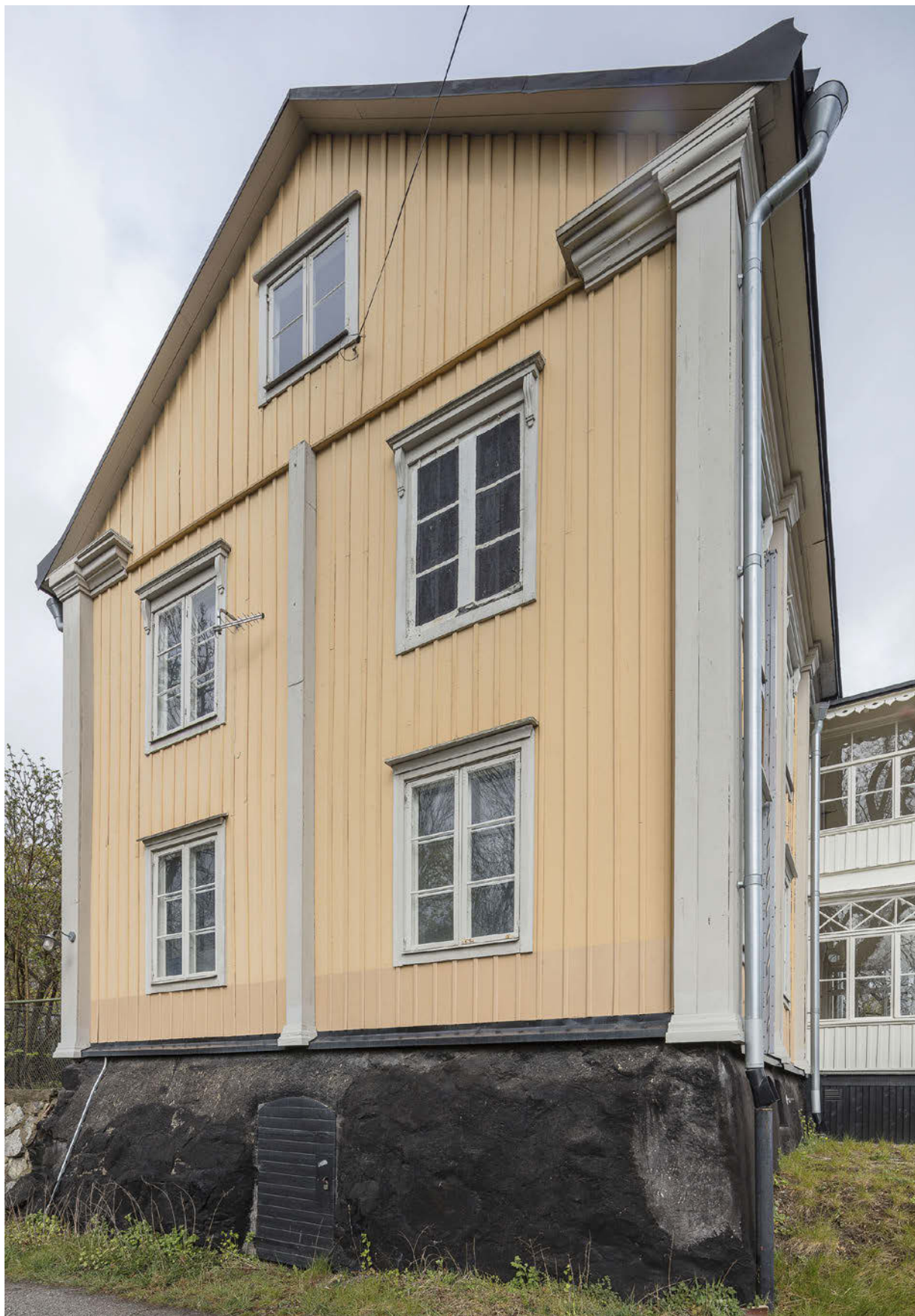
Huvudbyggnadens västra gavel. Bällsta gårds fönster har fönsterbeslag av både 1700- och 1800-talstyp. I bild syns ett blindfönster. Blindfönster var ett vanligt förekommande inslag under 1800-talet för att skapa en symmetrisk fasadindelning. SSM_10043442
