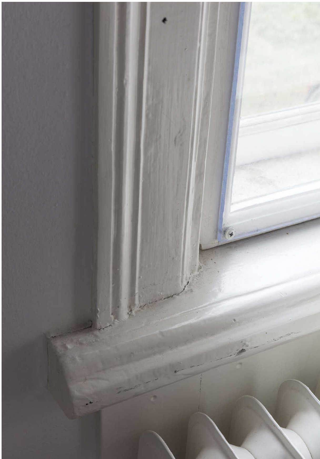
Fönsterfoder i rum 214 A visar på ett vanligt förekommande utförande på bottenvåningen, sannolikt från 1857. Fönsterbrädan är eventuellt ännu äldre. Foder och fönsterbrädor har stor betydelse för förståelsen av stildealet vid mitten av 1800-talet, eller tidigare, och har höga materialmässiga kvaliteter. SSM_IOO43342
