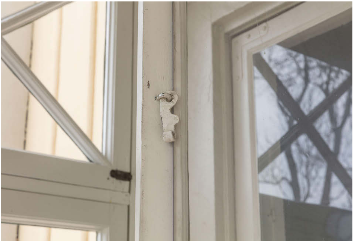
Ytterbågarna har haspar av både 1700- och 1800-talstyp. Sannolikt återbrukades byggnadsdetaljer från 1780-talets huvudbyggnad i samband med ombyggnaden år 1857. SSM_10043333
