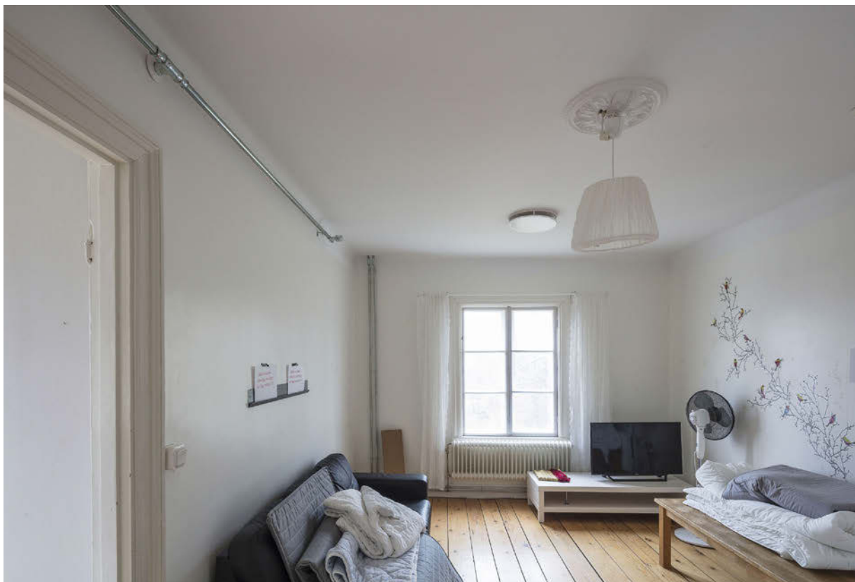
Rum 303 med vy mot väster. Till vänster i bild syns ett foder med kulknopp från 1850-talet. Karaktären kännetecknar stilen och beslagtagningen vid tiden och återfinns vid fler äldre öppningar inom våningsplanet. SSM_10043397
