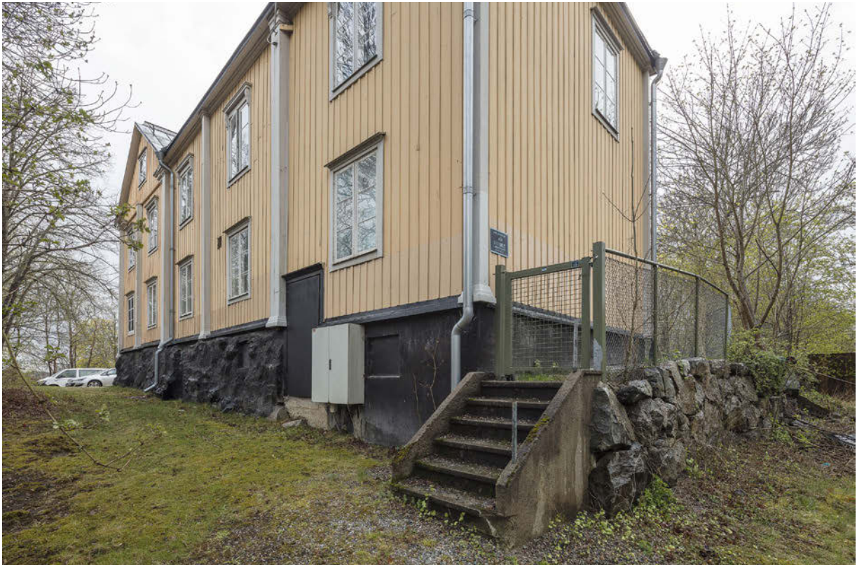
Tillbyggnaden mot norr förlängdes under tidigt 1900-tal. Den senare tillbyggnaden markeras framförallt genom sockelns släta betongyta. I den förlängda delen inreddes bland annat tvättstuga och badrum vilket vittnar om tidens moderniseringsbehov. SSM_10043457
