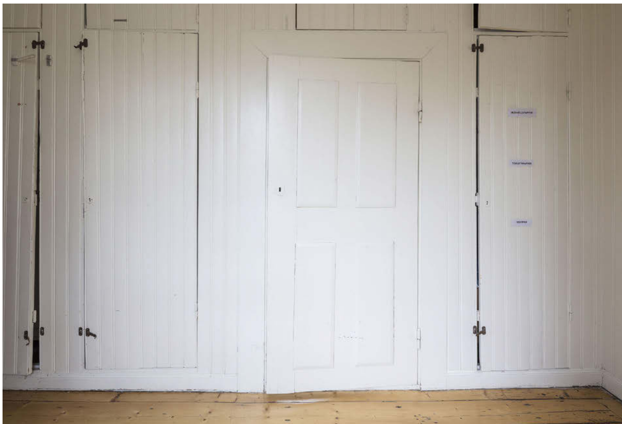
I serveringsgången, rum 217, finns ett dörrblad som är av 1700-talstyp och sannolikt husets äldsta, men som sitter på en sekundär plats. Fyllningsdörren har fyra utanpåliggande fyllningar. SSM_10043384
