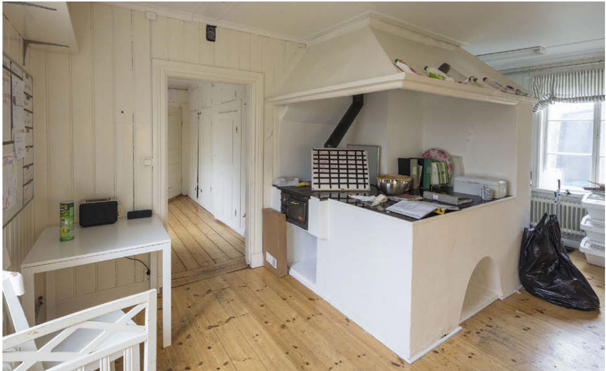
Köket byggdes 1857 och bevarar den äldre murade härden, delvis återuppbyggd på 2000-talet, samt kåpa. Sannolikt finns delar av den äldre panelen kvar vid den vänstra dörröppningen i bild. Köksspisen är en viktig symbol för rummets funktion och vittnar om när funktionen blev en del av bostadshuset. Tidigare var det placerat i en separat byggnad på gården. SSM_10043386
