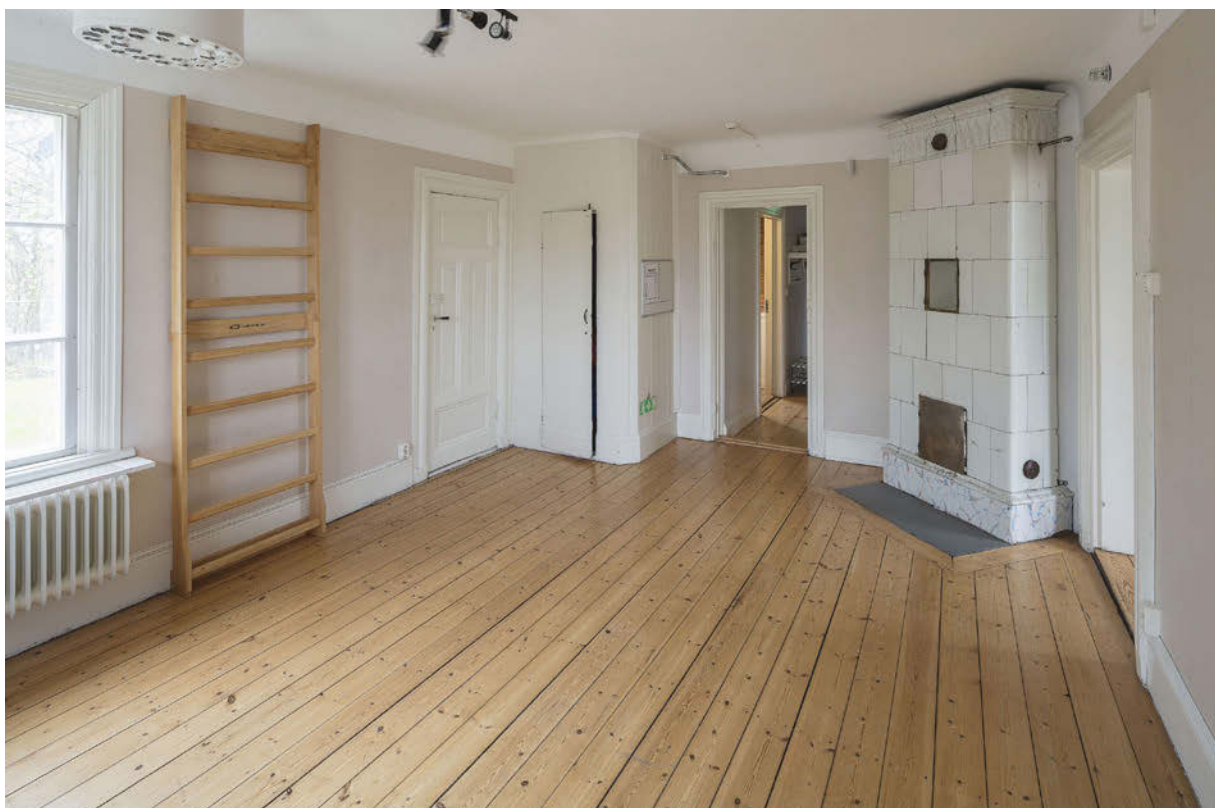
Rum 205 med vy mot öster. Rummets planform är sannolikt den enda kvarvarande från 1780-talet. Dörr- och fönsteröppningar omges av foder av sen rokokotyp, sannolikt 1780-tal. Kakelugnen är sannolikt från mitten av 1800-talet. SSM_10043357
