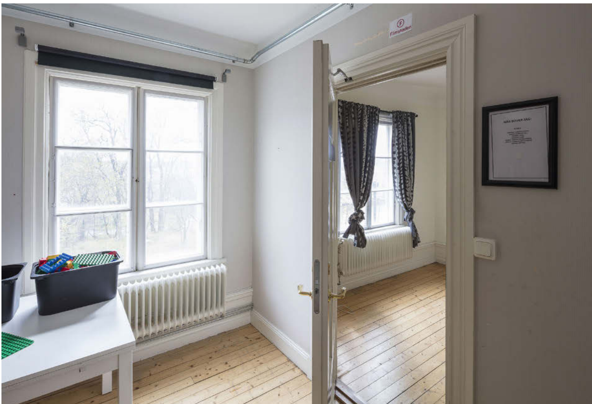
Rum 302B med vy mot rum 302A. Bilden visar hur den äldre fotsockeln går genom den sekundära mellanväggen och följer rummets ursprungliga planform. SSM_10043398
