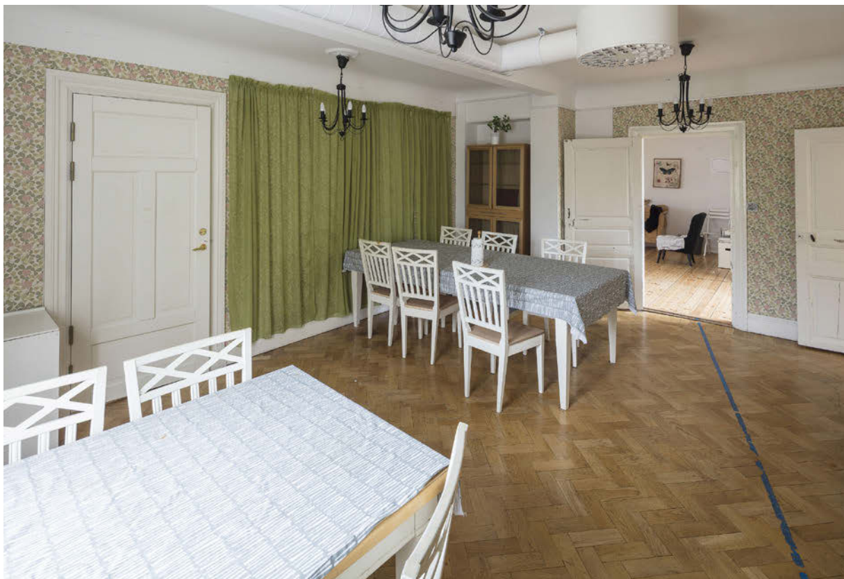
Rum 215 med vy mot väster. I rummet finns ett parkettgolv, sannolikt från 1920-talet. Den vänstra väggen i bild är sekundär och i taket finns en balk som vittnar om rummets äldre indelning. SSM_10043364
