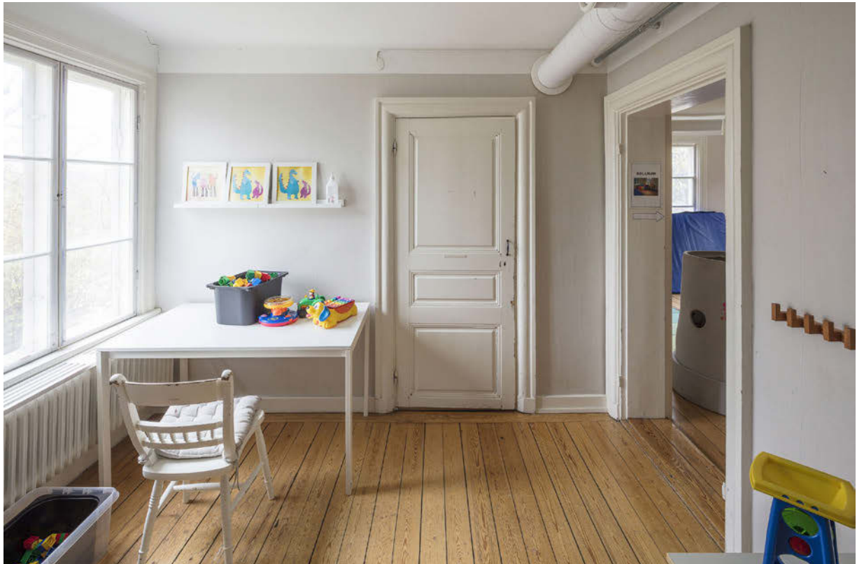
Rum 203 med vy mot väster. Dörrbladet rakt fram i bild härrör sannolikt från 1850-talet, och hänger på kulknoppsgångjärn från tiden kring 1800-talets mitt. Dörrbladstypen var vanlig under 1700-talets andra hälft och 1800-talets första, och förekommer på fler ställen inom byggnaden. SSM_10043346
