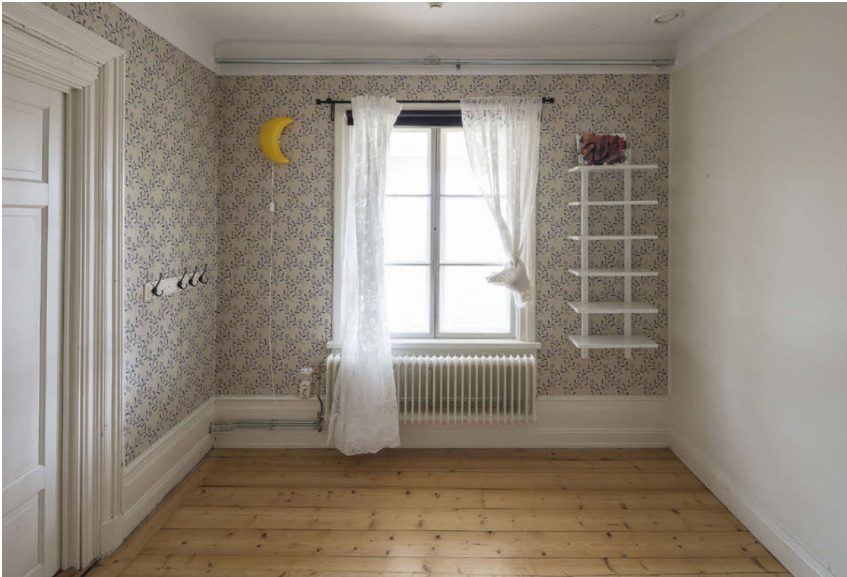
Rum 301B var ursprungligen en del av salongen. Fönster, fönsterfoder och bräda är från 1850-talet. Dörren till vänster i bild är sekundär och har passats in i en äldre öppning. SSM_10043414
