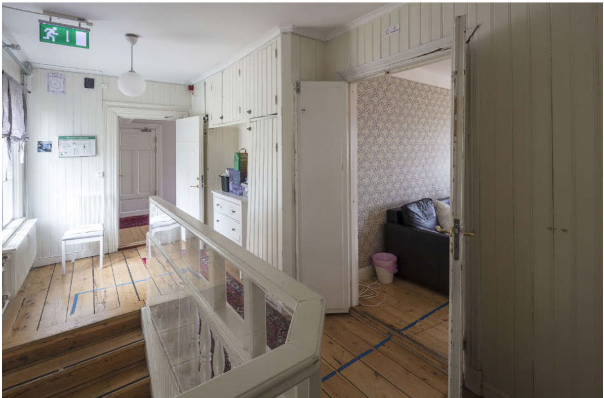
Hallen är inklädd i pärlspont och har platsbyggda skåp. Sannolikt är detta ett resultat från tidigt 1900-tal då den övre våningen inreddes som separat bostad. Till höger i bild syns äldre pardörrar till den f.d. salongen, dolda bakom sentida skivmaterial. SSM_10043375
