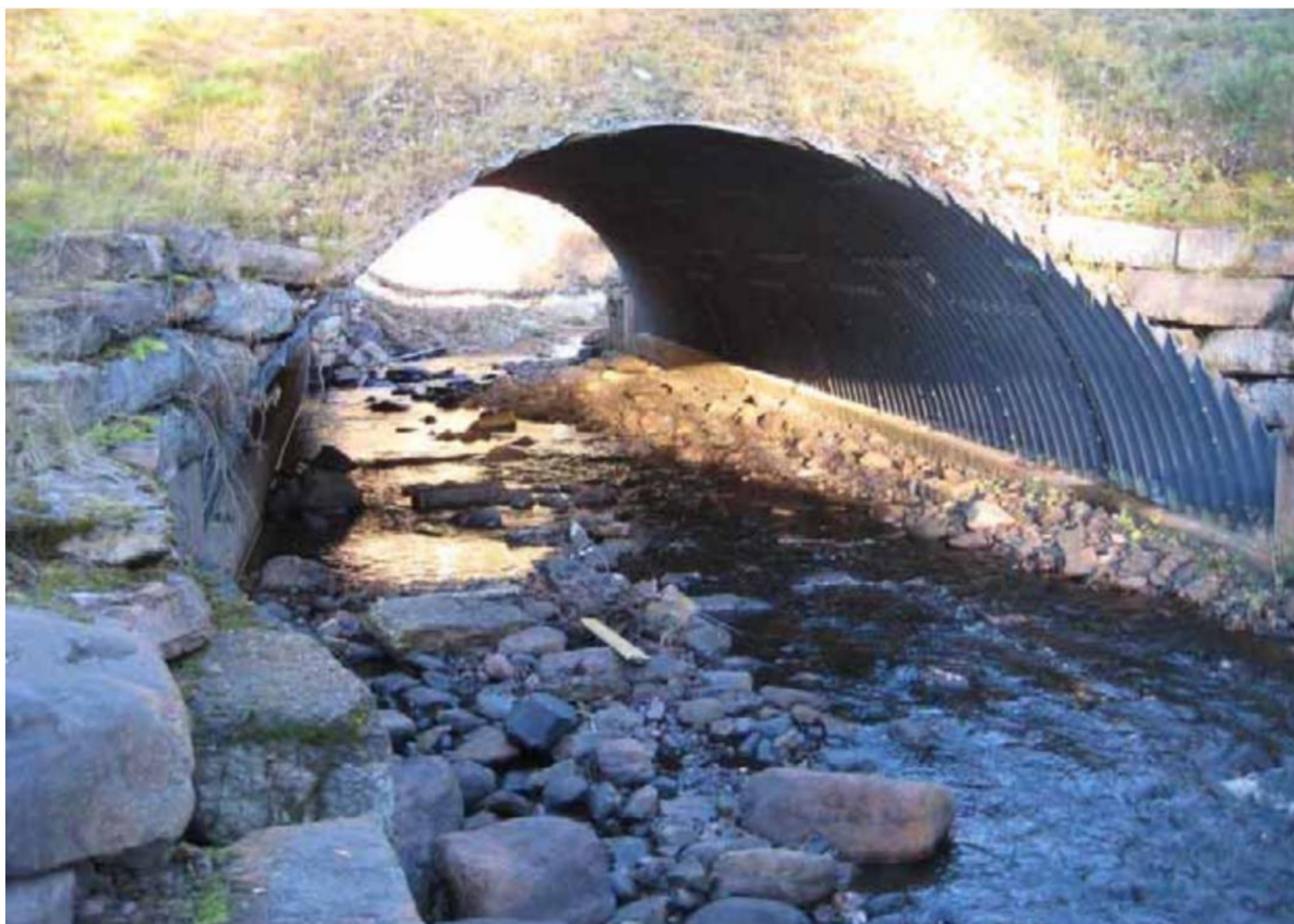
Figur 10. Exempel på en bred valvbåge, där vattendraget under vägen bevaras relativt opåverkat. Foto: Trafikverket.
