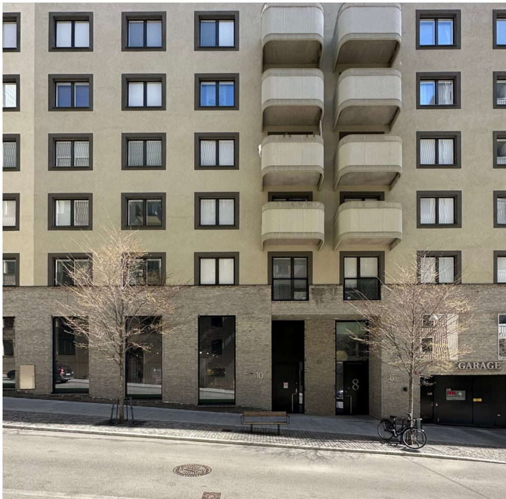
Referens sockelvåning i tegel med putsad fasad samt med omfattning fönster i avvikande kulör. Balkonger med sinuskorugerad plåt samt rundade hörn. Kv Anaylsen 2 / Einar Mattson
