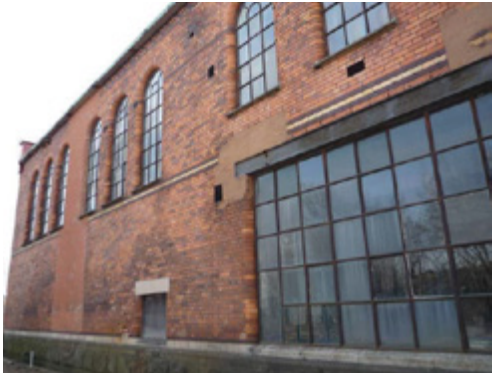
Norrfasad med murpartier repareerade med putsbruk och turbinhallens ursprungliga fönsterparti.
