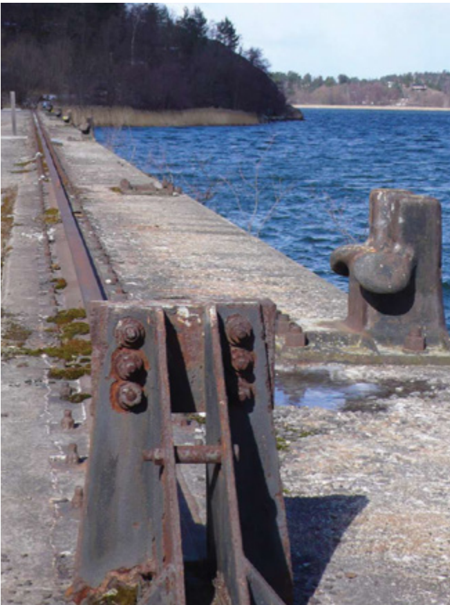
Kajen mot Värtan med pollare och del av kranbana. Kajen var platsen för lossning av råvaran kol och därmed en avgörande förutsättning för gasverkets placering
