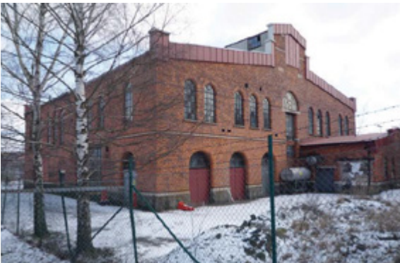
Västfasad med portar till produktionshall 4. I lanterninens mur, igensatt öppning ursprungligen för transportband.
