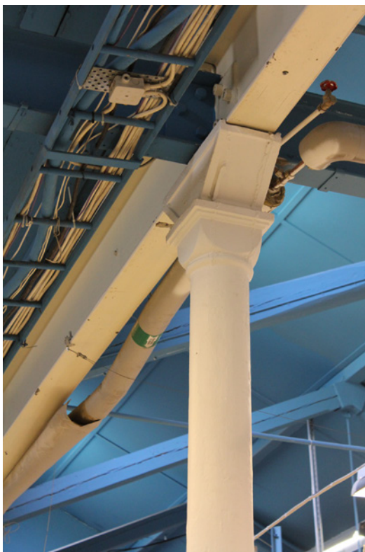
T.v. Sågtandens pelar- stomme med gjutjärn- skonstruktioner från 1890-tal. T.h. Sågtandens takfot med profilerade takfots- tassar och taklist
