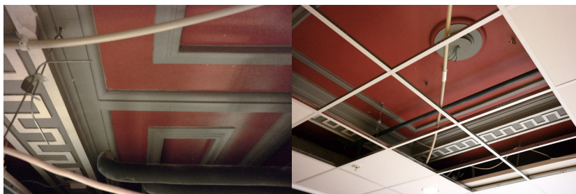
Bevarat, men ommålat, kassettak finns bevarat ovan akustiktakplattorna
