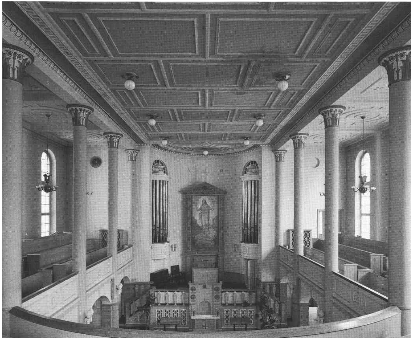
Stora salen sedd från läktaren. Kyrkbänkar i gradäng bakom lågt räcke. Takets indelningar, kassetter, friser och övrig detaljering är väl bevarad (möjlig vattenskada i takets mitt). I högdelen sitter globarmaturer mot ett blankt takfäste och över läktaren hänger nedpendlade ljuskronor från stora takrosetter. Till vänster syns ventilationsgaller för hiss. Till höger ses dörr till tidigare trapphus. Längs sidorna syns höga kyrkofönster. Altarets estrad, predikstol, orgel, altartavla och orgel i den halvcirkelformade nischen. Altarmålningen, målad av Natan Johansson, finns numera i Andreaskyrkan på Södermalm.
