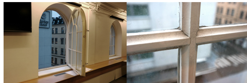
Ombyggda, bågformade fönster mot Pipersgatan, inre täckande isolerglas
