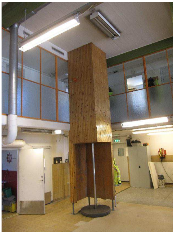
I korridorens båda ändar finns schakt med brandstäng som sträcker sig från övre planet ner till brandbilshallen.
