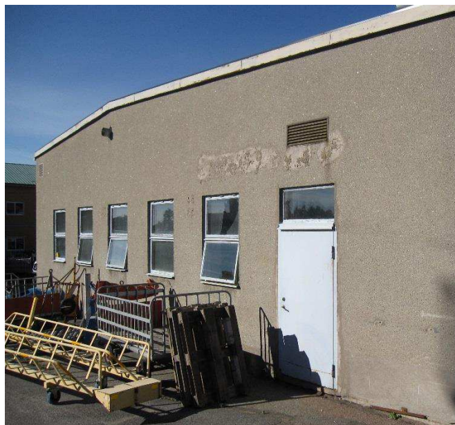
T v: Trappan på baksidan används inte. Betong och smidesräcke är välbevarade men i stort renoveringsbehov. T h: Södra gaveln med bevarad glimmerputs och ursprungliga fönster.
