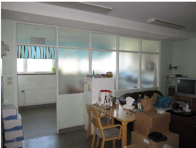
Två av de tre enheterna har kvar ursprungliga skärmväggar med låg bröstning och råglas mellan det som ursprungligen var omklädningsrum och matrum
