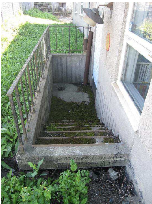
T v: Trappan på baksidan används inte. Betong och smidesräcke är välbevarade men i stort renoveringsbehov. T h: Södra gaveln med bevarad glimmerputs och ursprungliga fönster.
