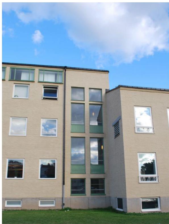
Stora gröna enluftsönster med plåtbröstning markerar trapphuspartiet mellan den södra och den mellersta byggnadsvolymen. Foto: ur Tyréns förundersökning.
