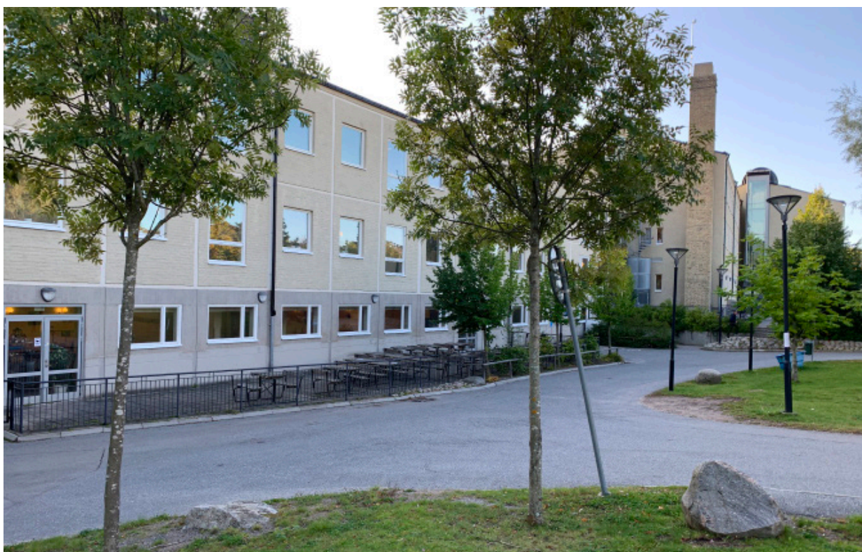
E-husets västra fasad, mot Möjbrovägen är tillskillnad från gårdsfasaden i en beige kulör. I bottenvåningen är fasaden i målad betong med en grå putsad sockel. Det vita listverket återkommer även i denna fasad. Utanför matsalen finns en inhägnad uteplats med bänkar.
