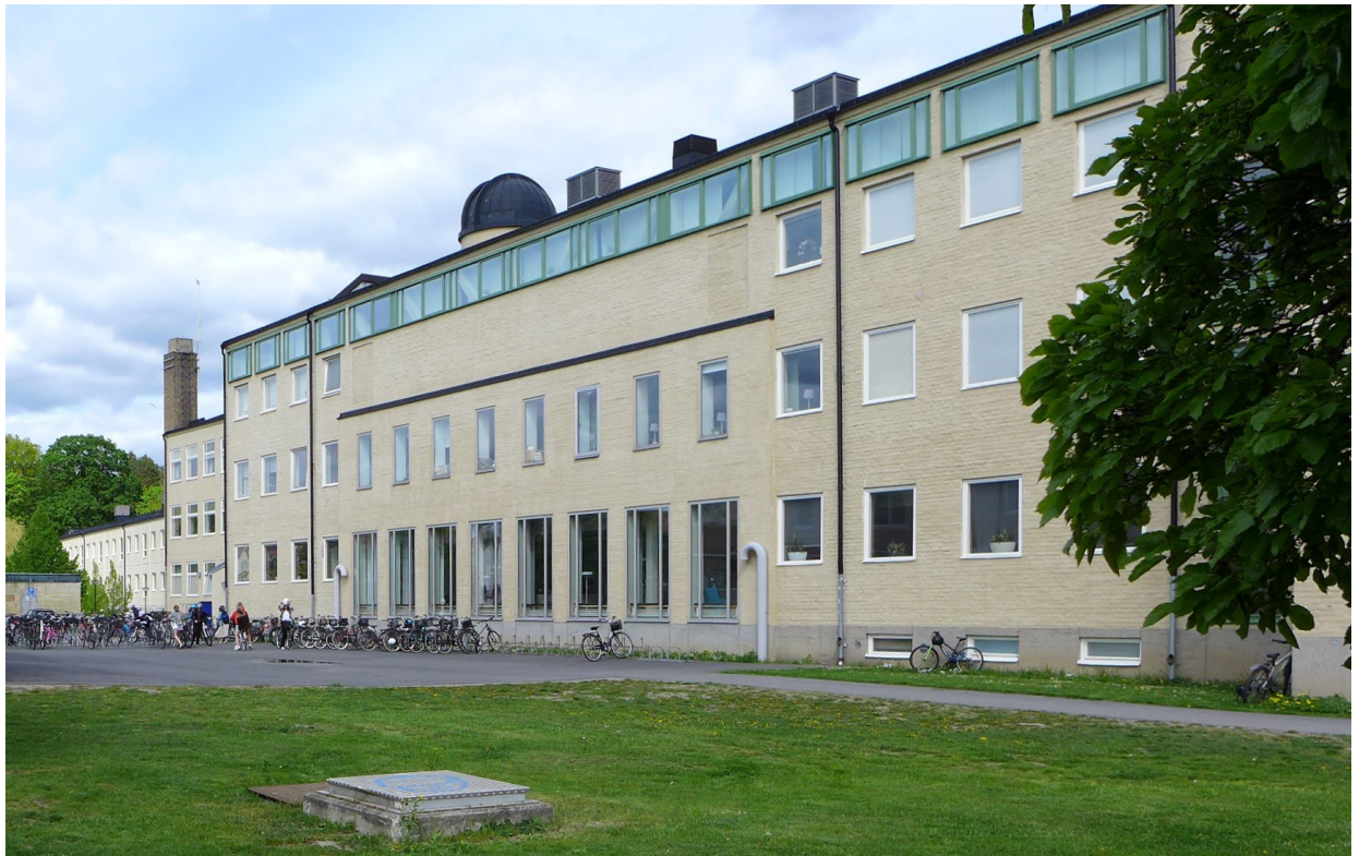
A-husets fasad mot Möjbrovägen i väster. Här syns spår efter den planerade aulans placering i fasaden. Fasaden gjordes om i början av 2000-talet med nya fönster med bågar av aluminium. Två ursprungliga fönster på våning 2 murades igen vid samma tillfälle.
