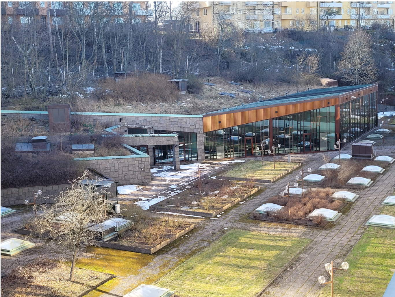
Köks- och serveringsbyggnaden i fastighetens inre är en utbredd volym som maskerats som en del av slutningen genom bevuxna taktytor och omfattande stödmurskonstruktioner. Bilden tagen från KM-husets takterrass.
