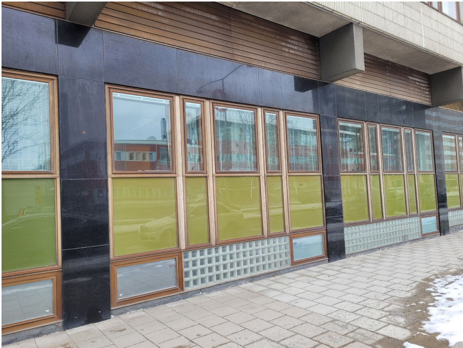
Befintlig utformning där en fönstersättning anpassad för kontorsanvändning infogats i en annars arkitektoniskt tydlig bottenvåning. Glasblock kombinerat med fönster svarar för dagsljusinsläpp till källaren.
