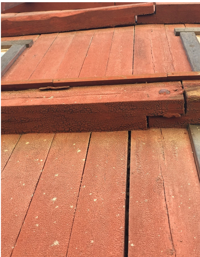
Bild 41: Karaktäristisk krackelering av rödfärg infuserad med linolja.
