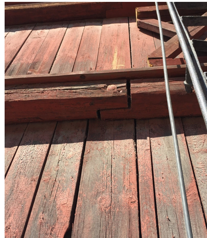
Bild 42: Skärmarna är infästa med vagnsbultar.
