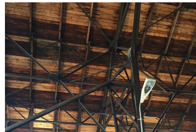
Ovan: Bild 46-47: Skärmväggarna är otäta och bemålade med färg som flagnar. Undertaket är i huvudsak utbytt.
