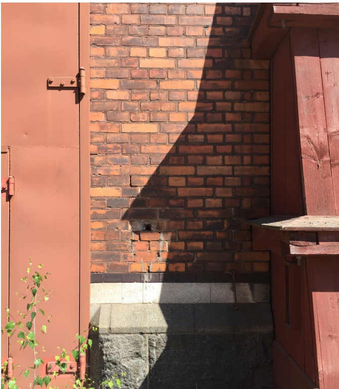
Bild 39: Tegelfasaden möter trä och sockel av granit.
