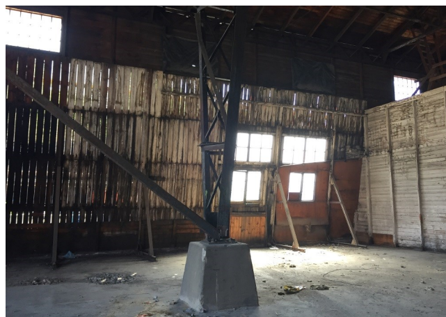
Ovan: Bild 44-45: Infästningarna avslöjar var ursprungsstrukturen förstärkts.
