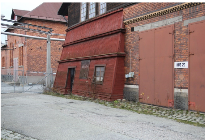
Bild 40: Träskärmarna lutar med en bredare bas.
