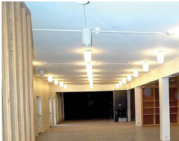
Tre Vapen 2, f.d. Bibliotek i hus D, Betongtak vitmålat med utanpåliggande belysningsarmatur, vitmålade väggar, fasta bokhyllor och golv av asfaltplattor. Antikvarisk förundersökning 2005, Per Nelson Byggnadsvårdsbyrå.
