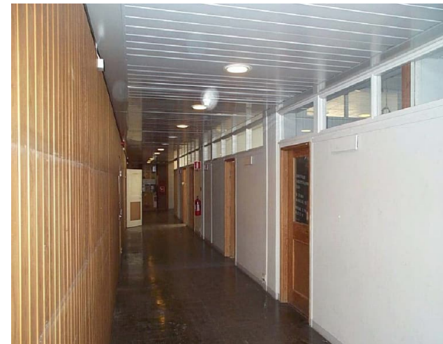
Tre Vapen 2, korridor hus E. Undertak av aluminium med infällda belysningsarmaturer, mellanvägg av obehandlad furupanel, golv med asfaltplattor och enkla furudörrar i spegelutförande av oljehärdade träfiberskivor (masonit). Högt placerade ljus ledde in dagsljus till korridoren. Antikvarisk förundersökning 2005, Per Nelson Byggnadsvårdsbyrå.
