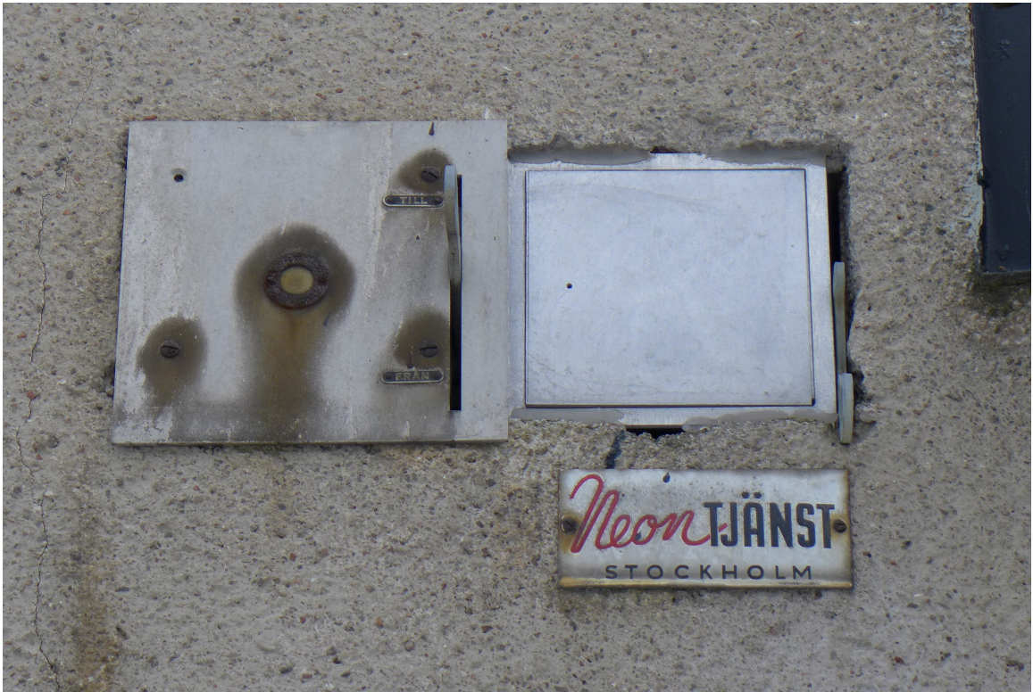
Äldre skylt och igensät- tningar med plåt i fasad mot norr.
