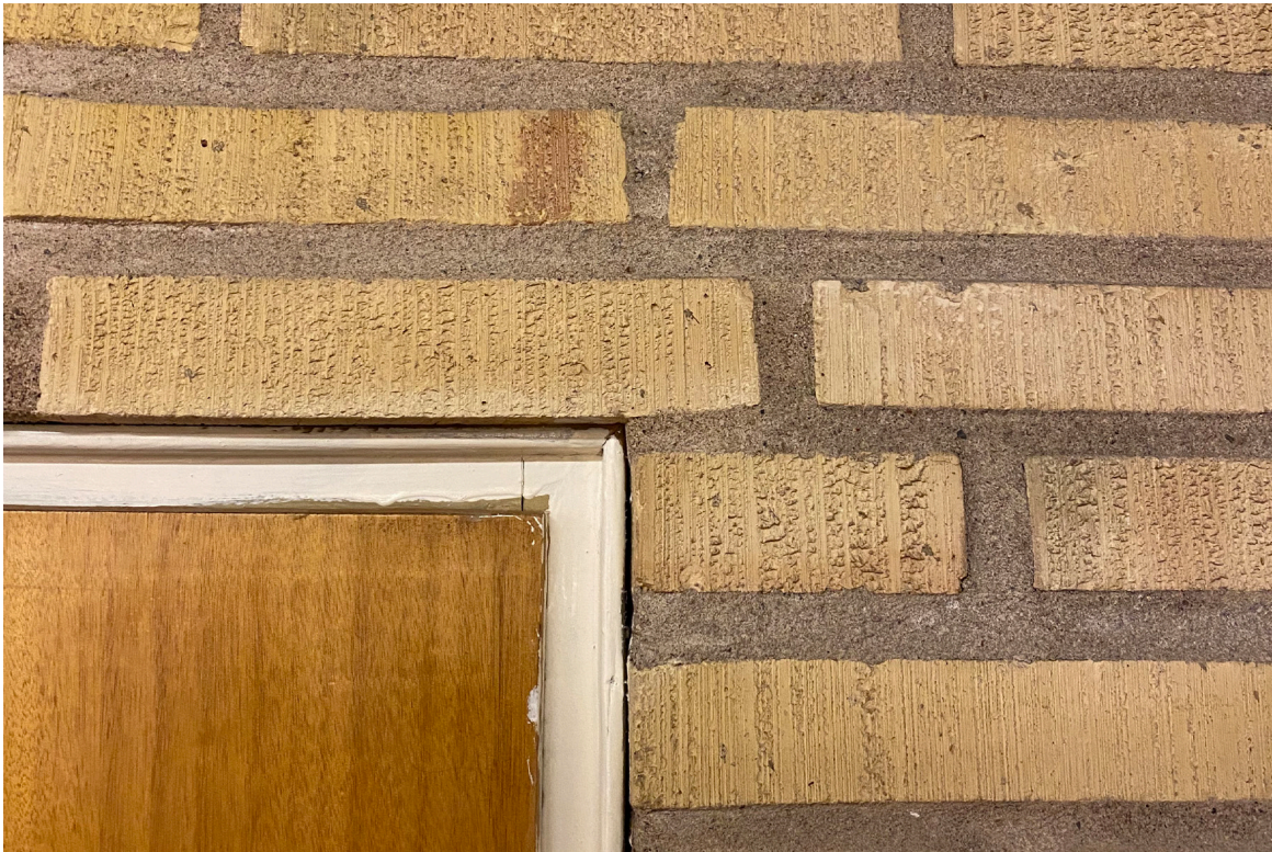
T h Detalj av invändigt tegel och fanérdörr med infälld karm.
