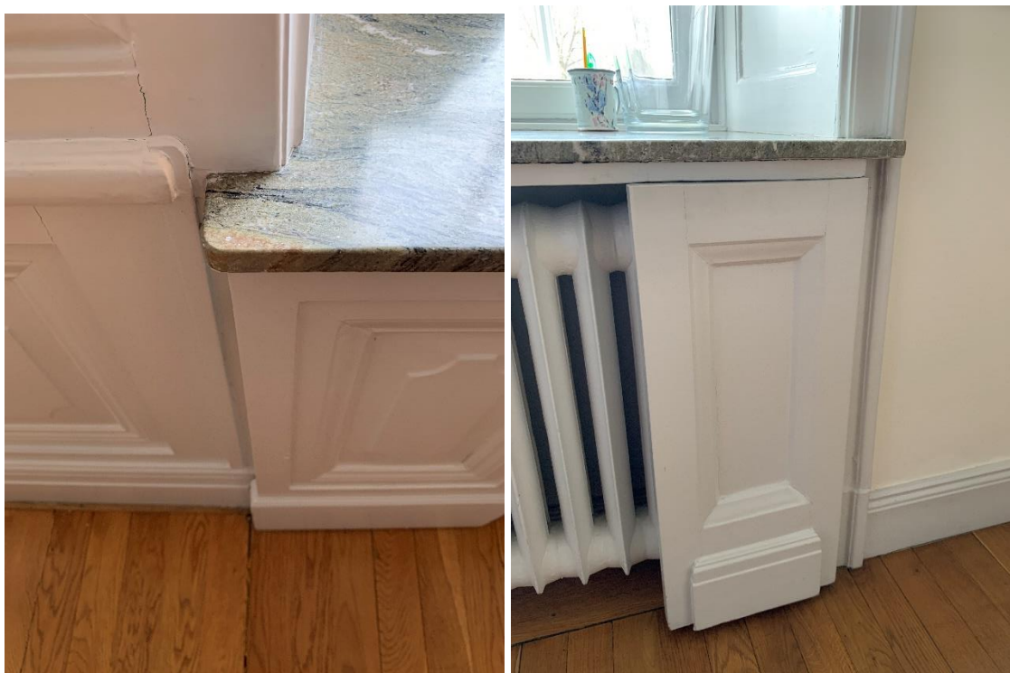
Fönsterbänkar av kolmårdsmarmor, radiatorer och radiatorskydd.
