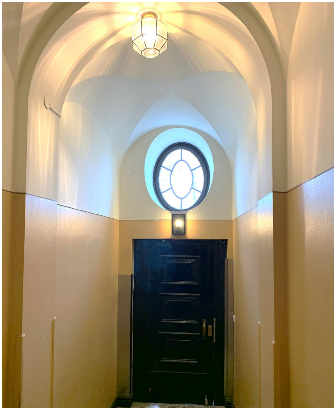
Ytterport av trä med beslag, ovalt fönster – oxöga, takvalv.
