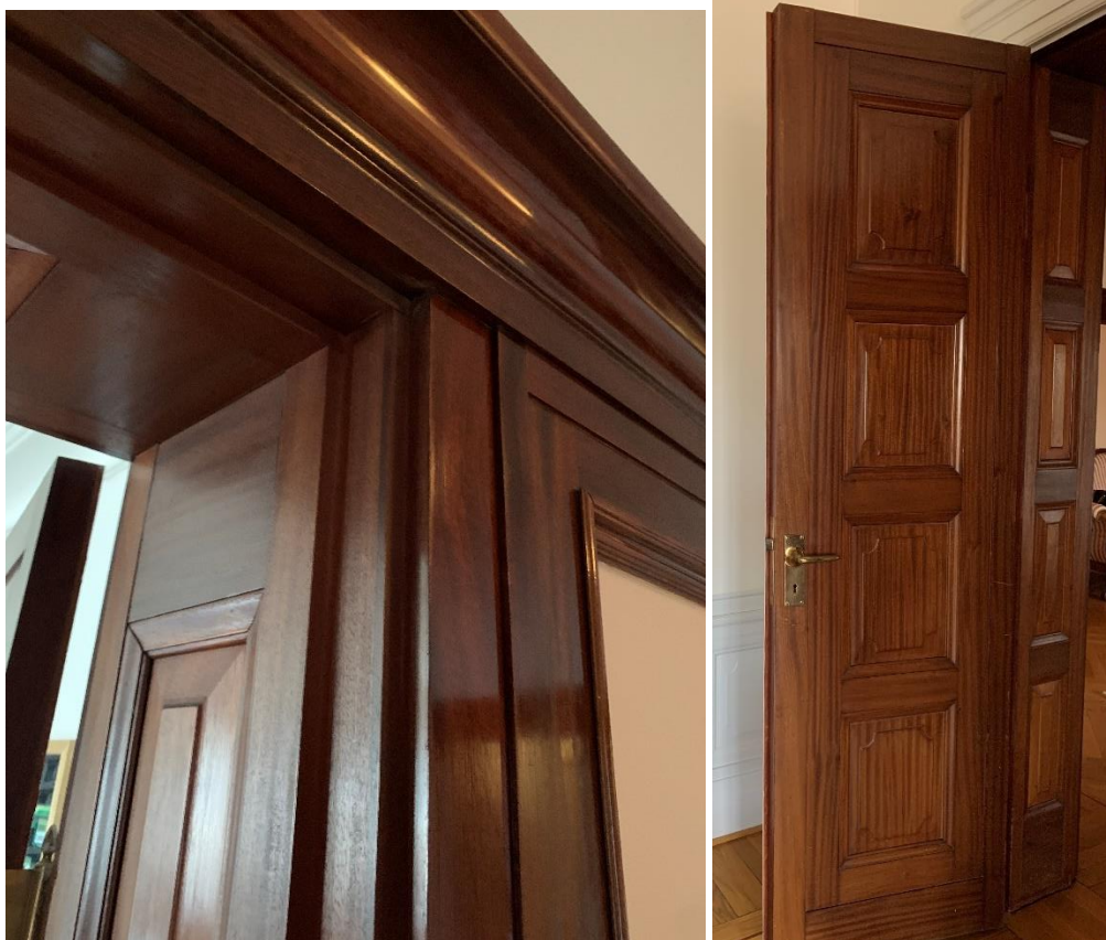
Vägg- och taklister samt smygpanel och pardörr av mahogny. Beslag av mässing
