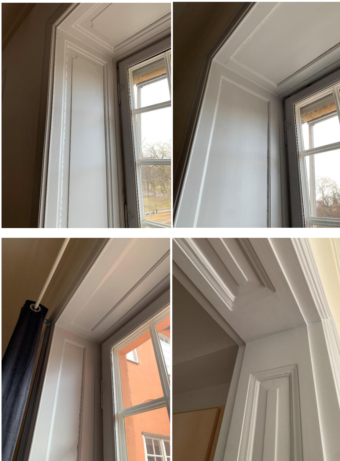
Olika typer av fönster- och dörrsmygpanel
