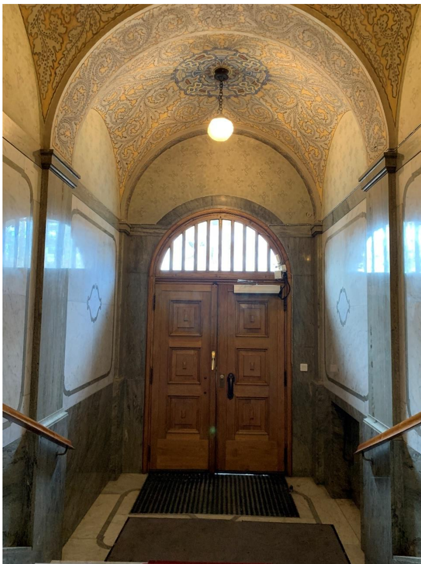
Ytterport av ek med överljus, beslag och handtag.
