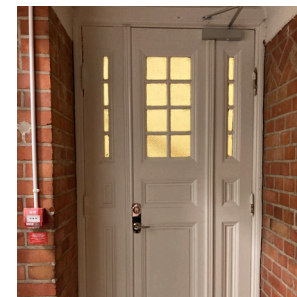
Fyllningsdörr med glaspartier i färgat mönsterpressat glas och spröjs.
