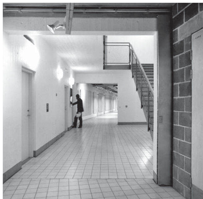
Ovan: Passage vid norra trapphuset, med skjutbar branddörr dold i en slits i väggen. T.v. norra trapphuset med räcken av stålror och ståltrådsnät. Foto: Sten Vilson.1970. (Informant 1)
