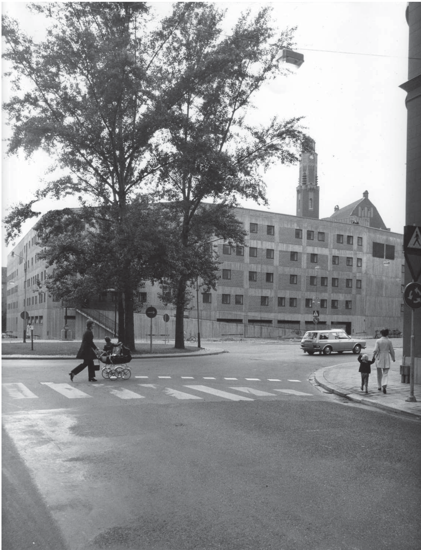
Fasaderna mot Rådmansgatan, Danderydsplan och Östermalmsgatan är av platsgjuten betong och murad betongsten. I bakgrunden skymtar Engelbrektskyrkans tegelbyggnad. Foto: Sten Vilson 1970. (Informant 1.)
